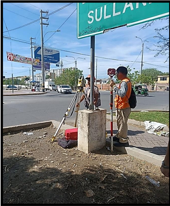
Figura 05: levantamiento topográfico en la Av. Andrés Avelino Cáceres
