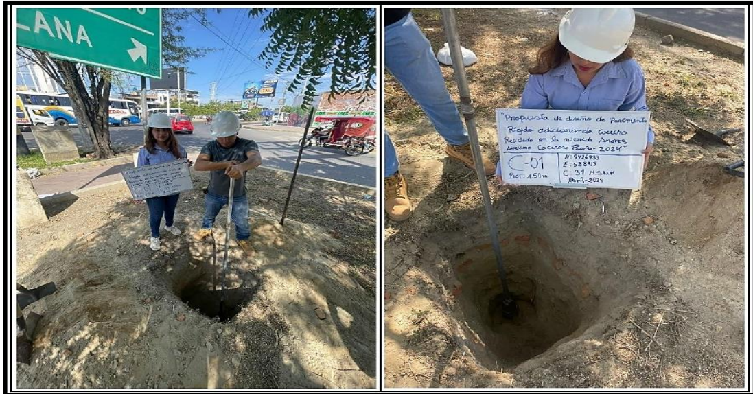
Figura 3: Excavación de calicatas para el estudio de suelos
