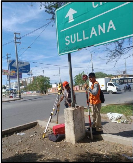
Inicio de levantamiento topográfico
