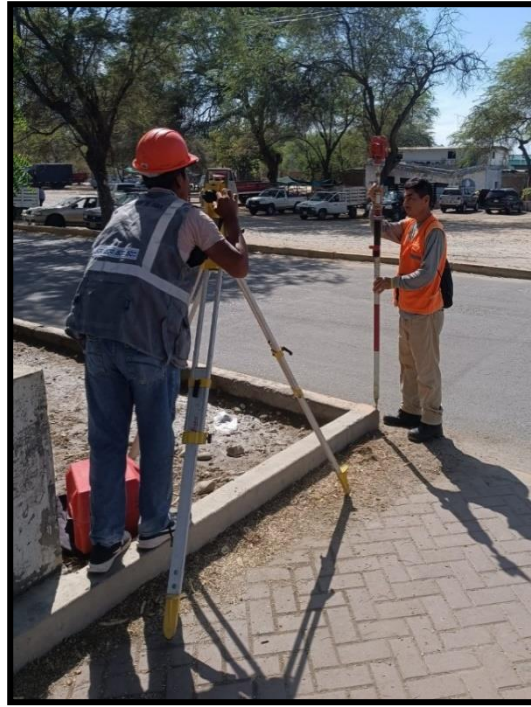
Figura 05: levantamiento topográfico en la Av. Andrés Avelino Cáceres
