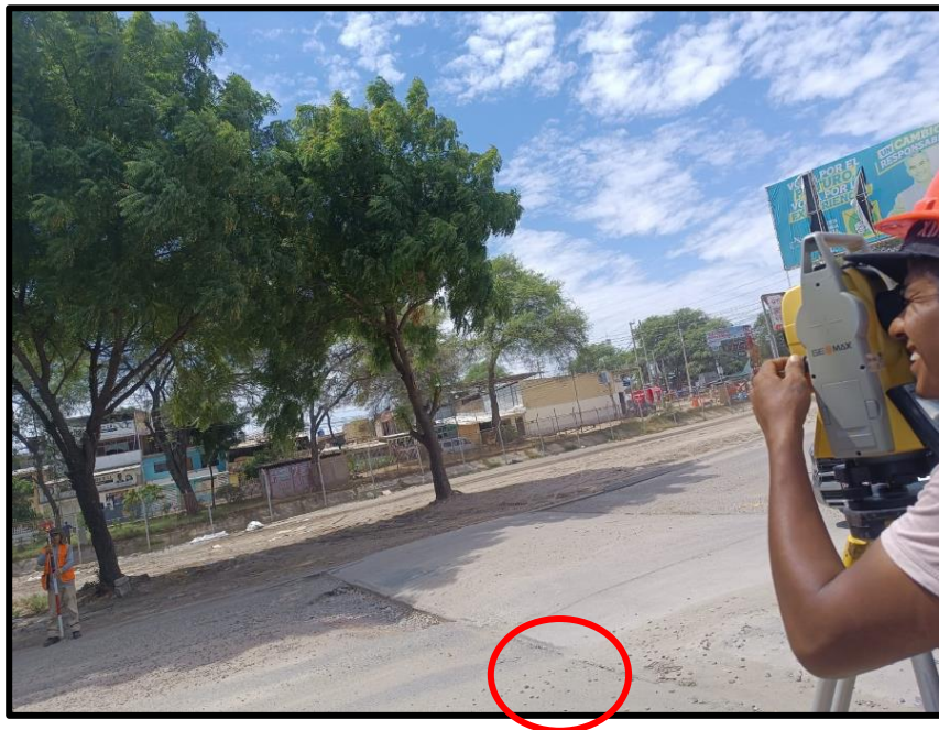
Finalización de vía, BM 6
