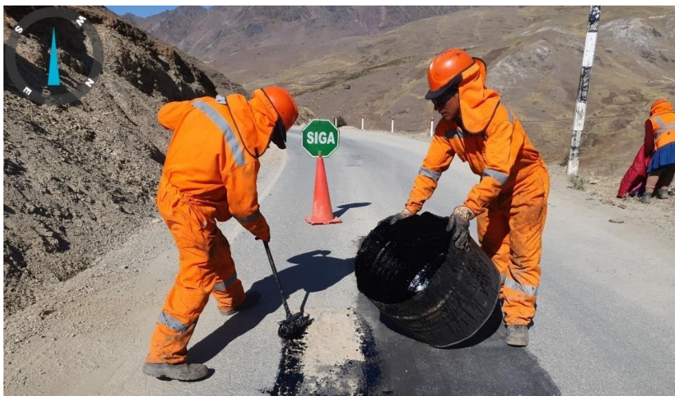
Figura 5.1. Procedimiento para el colocado de la mezcla asfáltica incorporando policarbonato
