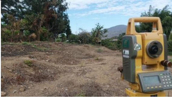
FOTO 03: Indica el trabajo de campo para levantar el terreno existente.
