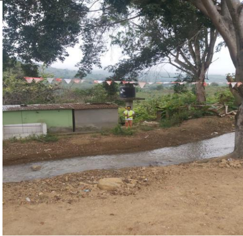
FOTO 09: Indica el trabajo de campo para levantar el terreno existente.
