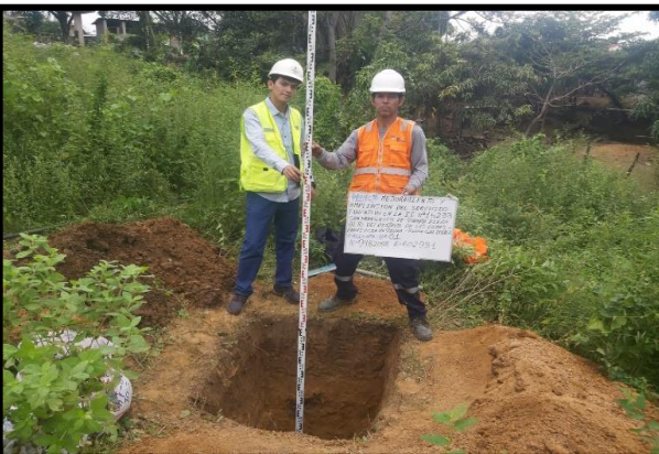
FOTO 05: Excavación para calicata N°5
