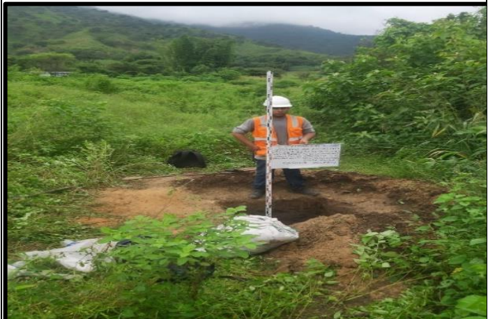
FOTO 04: Excavación para calicata N°4
