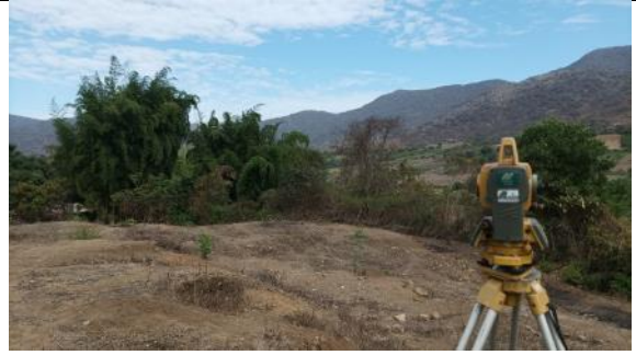
FOTO 04: Indica el trabajo de campo para levantar el terreno existente.
