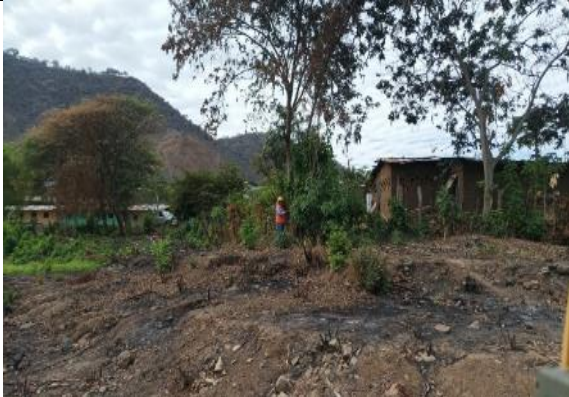
FOTO 05: Indica el trabajo de campo para levantar el terreno existente.
