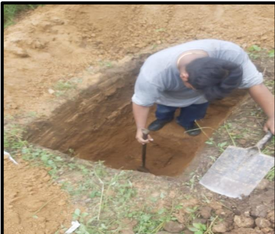
FOTO 03: Excavación para calicata N°3
