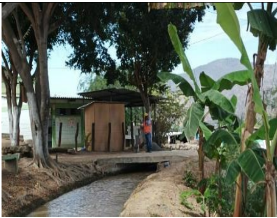
FOTO 11: Indica el trabajo de campo para levantar el terreno existente.
