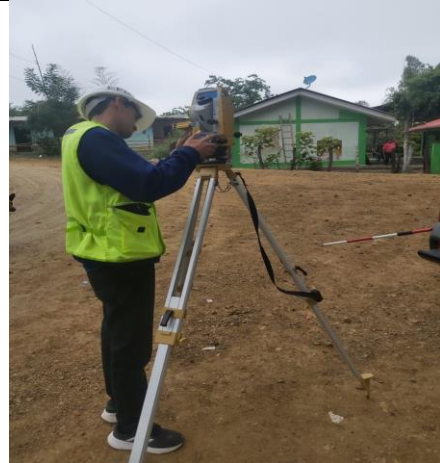
FOTO 10: Indica el trabajo de campo para levantar el terreno existente.
