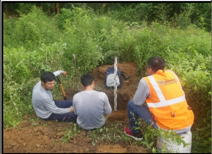
FOTO 02: Excavación para calicata N°2
