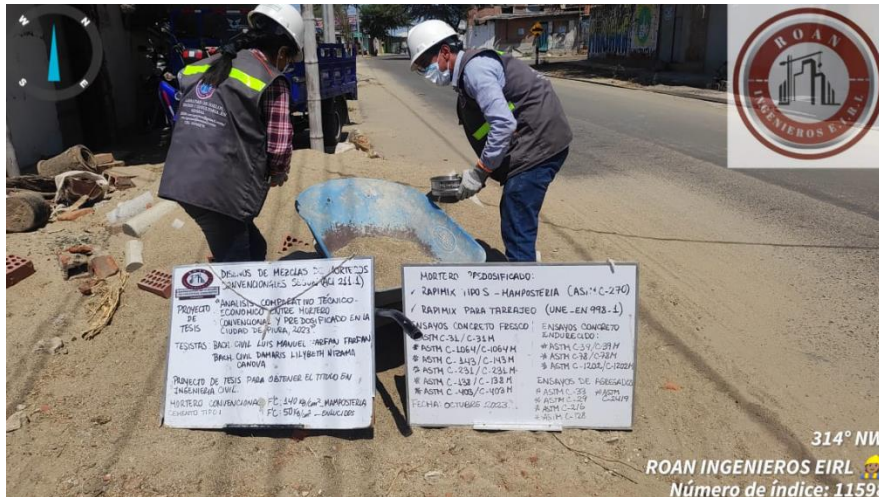
Toma de muestra del agregado
