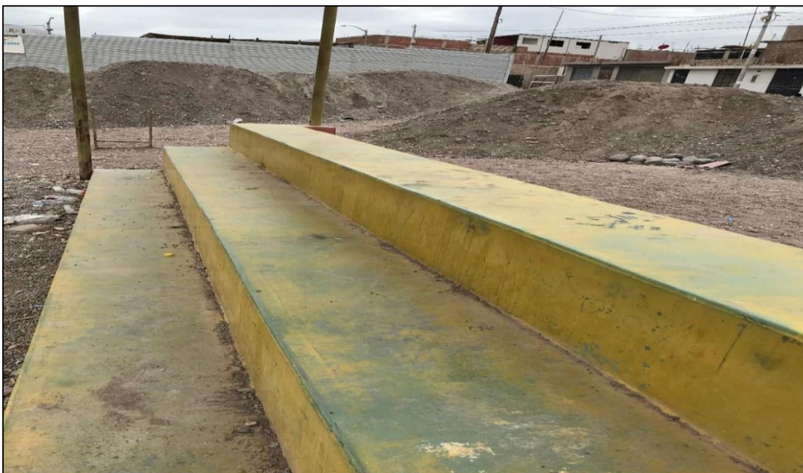
Figura 20. Trayectos peatonales con agregados granular
