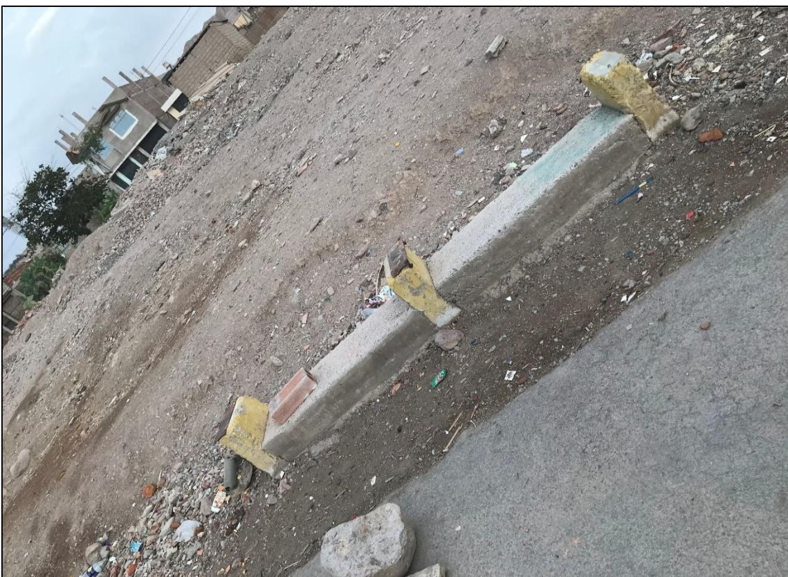
Figura 31. Estructura de materia pétreo y hormigón
