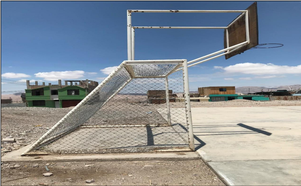
Figura 14. Capacidad estructural limitada
