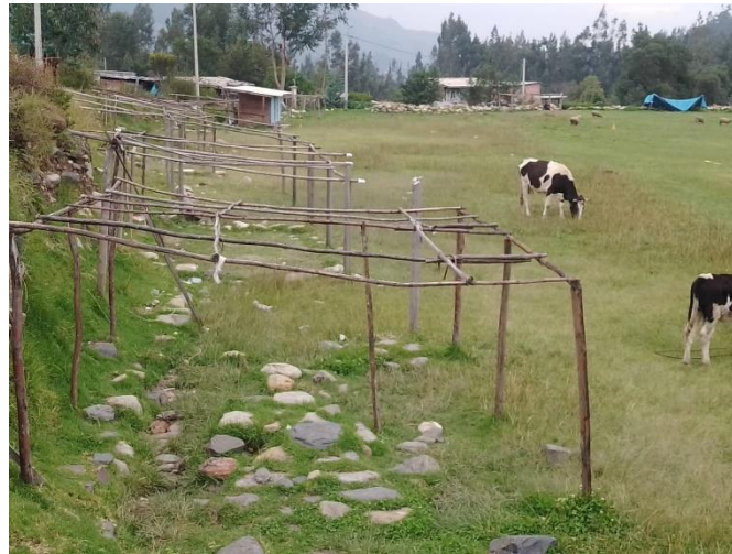
Figura 22. Camerinos en estado precario.
