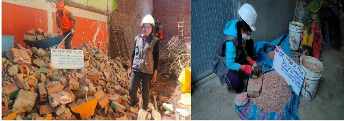
Figura 11. Sitio de reciclaje de escombros y moliendo agregados
