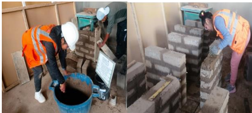
Figura 25. Elaborando los muros de 15x62x62cm2
