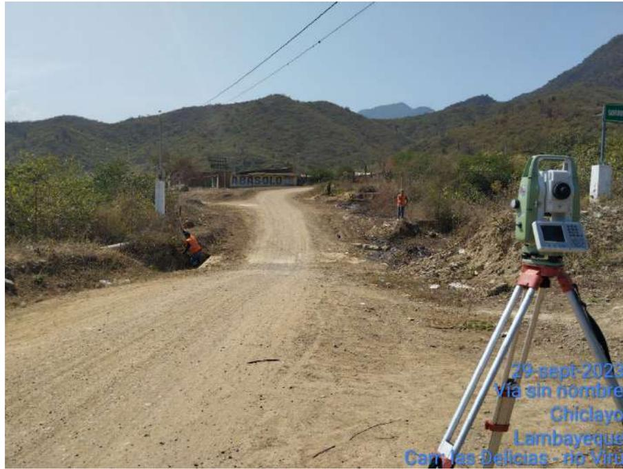
Fotografía 16: estudio topográfico en el km 10+185 final de tramo
