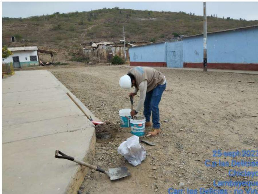
Fotografía 02: monumentación de hitos de concreto 30x30 cm cada 500 metros para el control planimétrico y altimétrico.
