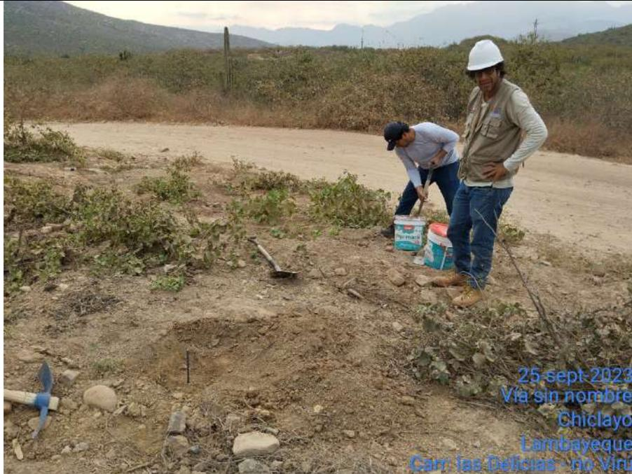
Fotografía 03: monumentación de hitos de concreto 30x30 cm cada 500 metros para el control planimétrico y altimétrico.
