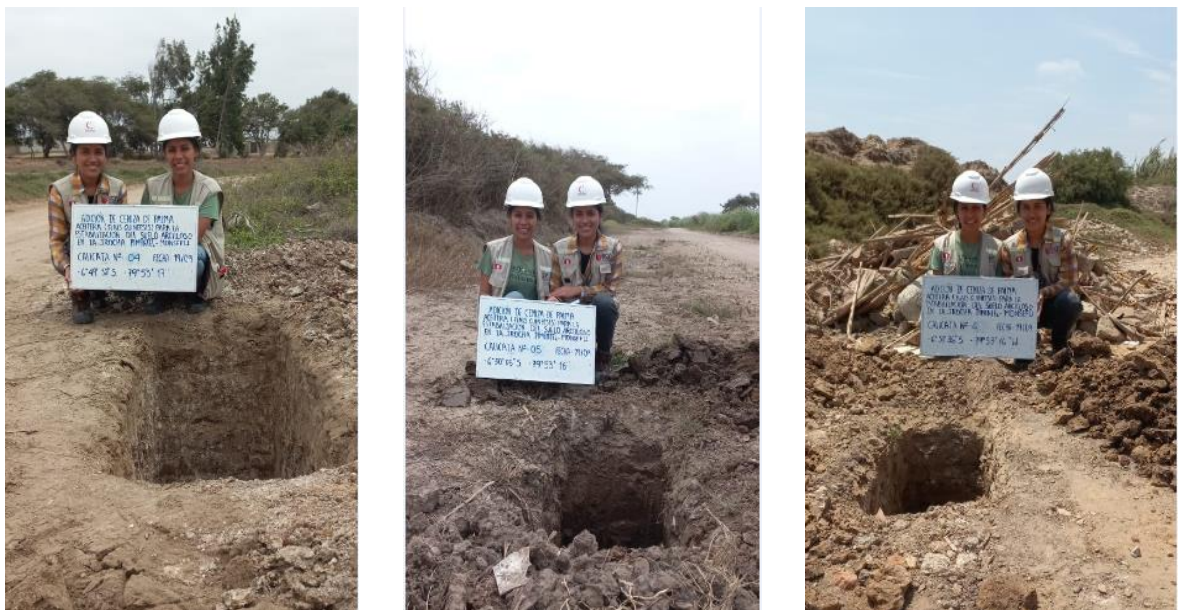
Figura 29 Excavación de Calicatas: C4, C5 y C6.
