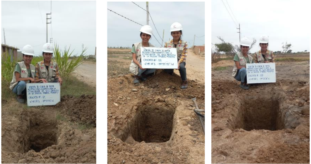
Figura 28 Excavación de Calicatas: C1, C2 y C3.
