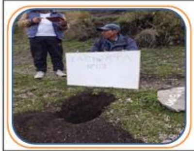
Foto: 01: Excavación de calicatas N° 01
