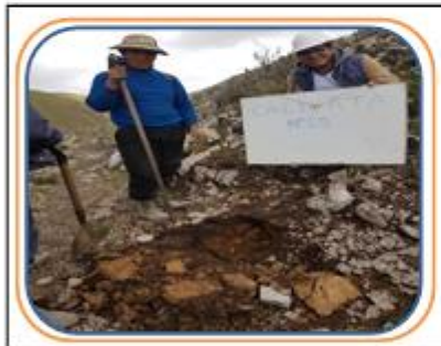
Foto: 03: Excavación de calicata N° 02
