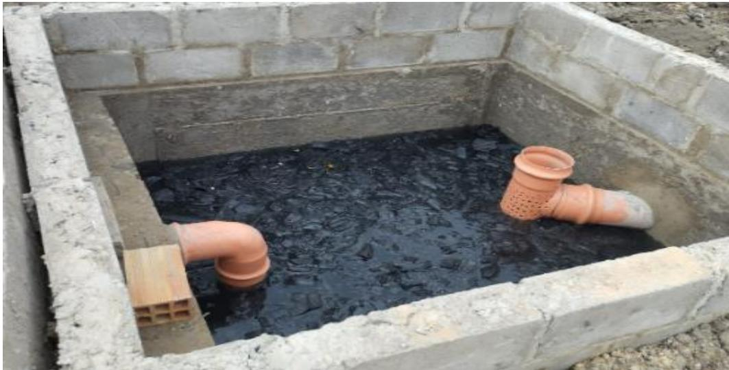
Esquema de representación del tratamiento terciario: con carbón activado, que permite eliminar los agentes patógenos, turbidez, PH, alcalinidad.
