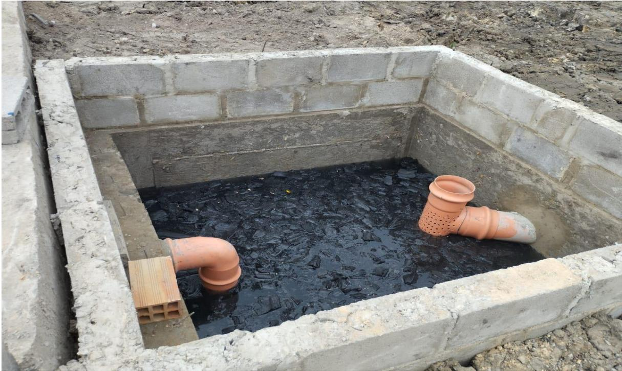
Vista fotográfica de la Quinta 24 de agosto, cámara de filtración de carbón activado en funcionamiento.
