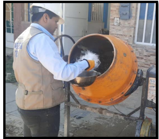
INCORPORACIÓN DE LA F.V. EN LA MEZCLA DE HORMIGÓN
