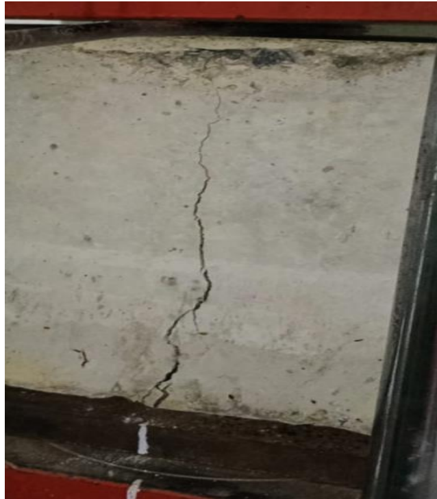
Figura N° 62. Visualización de la falla por flexión luego de la carga aplica al centro de la viga experimental.
