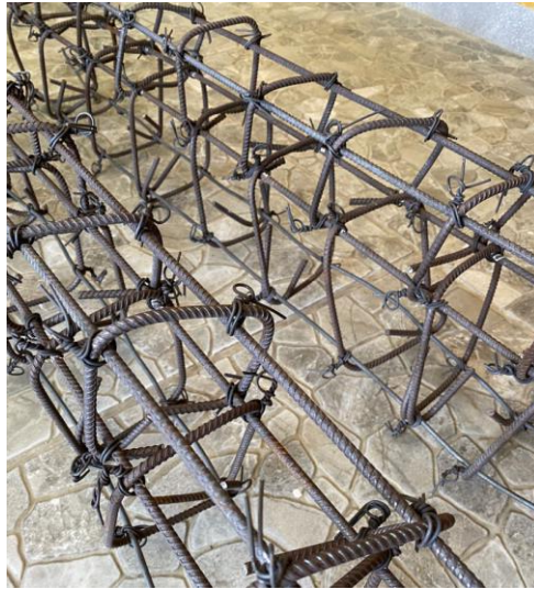
Figura N° 42. Habilitación y armado de acero destinado para elementos prismáticos
