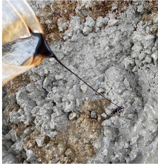
Figura N° 50. Preparación de concreto haciendo uso de aditivos para mejorar trabajabilidad.
