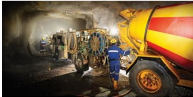
figura 6. tecnología para el refuerzo del concreto lanzado (shotcrete), (PRODIMIN, 2023)
