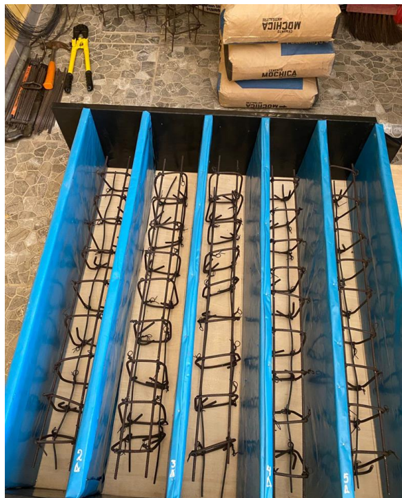
Figura n° 44. Armadura introducida dentro de encofrado
