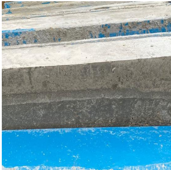
Figura N° 57. Desencofrado de elementos prismáticos de concreto armado tipo viga.
