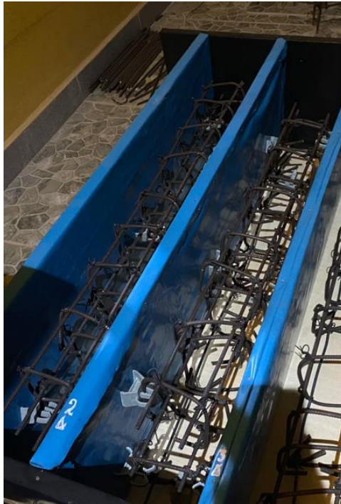
FIGURA N° 47. Vista lateral del acero introducido en el encofrado con colocación de separadores.
