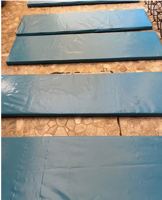
Figura N° 39. Madera cubiertas con plástico a utilizar para el encofrado.
