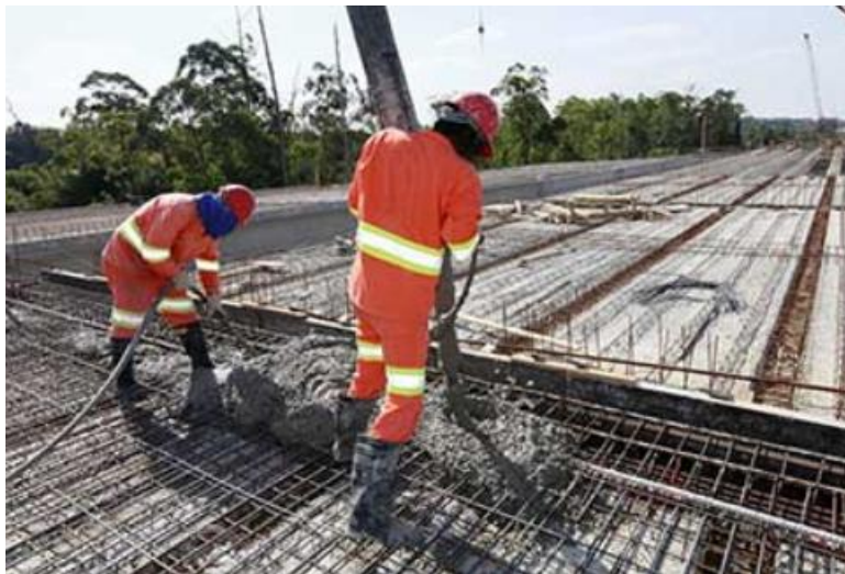
figura 2. proceso de vaciado en losa aligerada. (EUROINNOVA, 2023)
