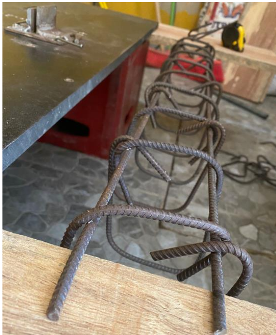
FIGURA N° 41. habilitación de acero para elementos prismáticos
