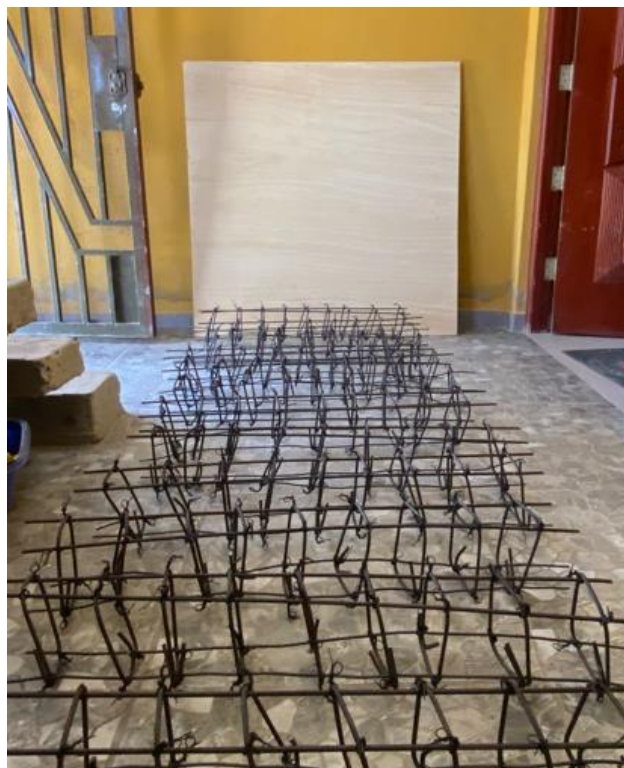
Figura N° 43. Vista de la armadura destinada para los elementos prismáticos.
