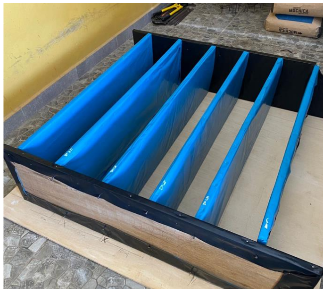
Figura N° 40. Maderas cubiertas con plástico a utilizar para el encofrado.
