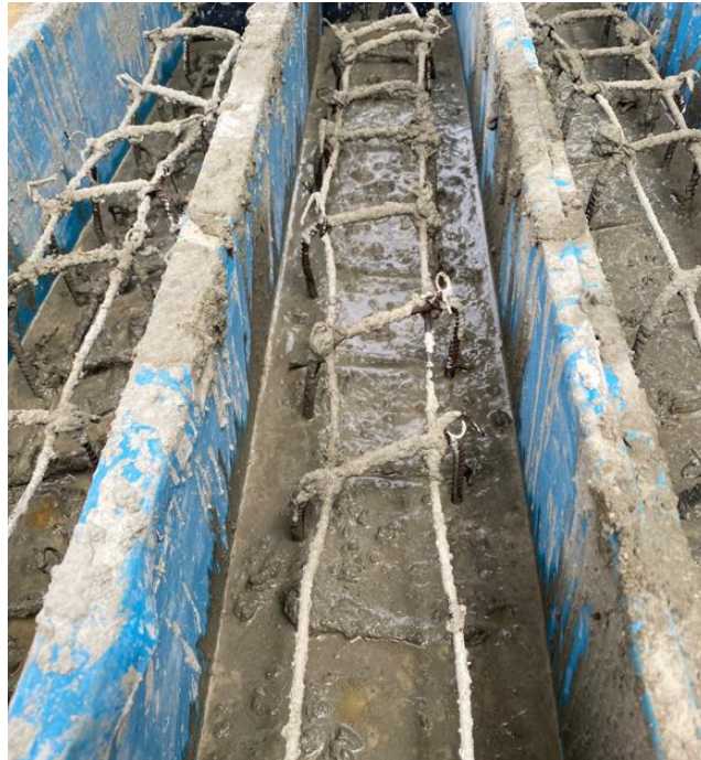
FIGURA N° 54. Elementos prismáticos destinadas para el reforzamiento.
