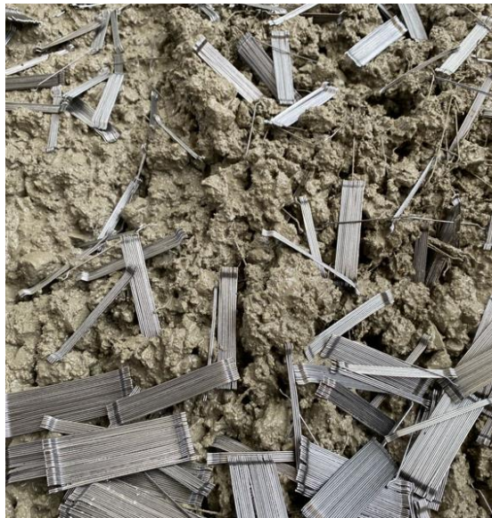
Figura N° 51. Adición de fibras de acero destinado para el reforzamiento estructural
