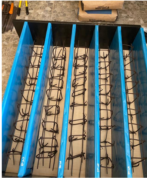
Figura N° 48. Prueba de la colocación del acero dentro del encofrado.
