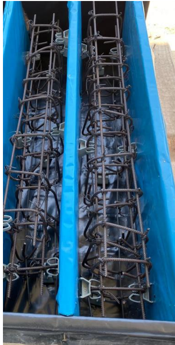
Figura N° 45. Armadura introducida dentro de encofrado con colocación de separadores
