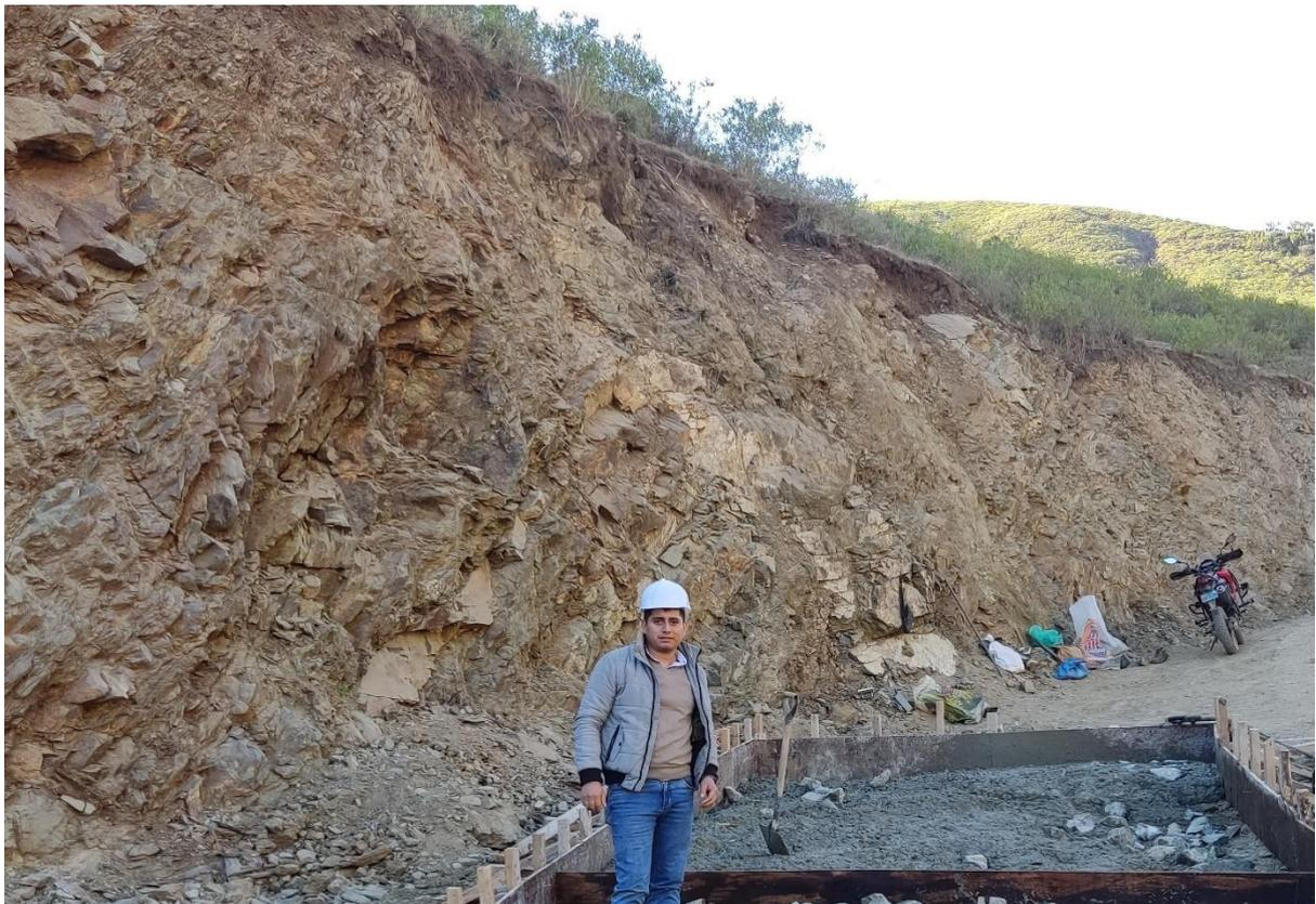
*Fotografía 06:* Vaciado de concreto simple en badén en rehabilitación de camino vecinal
