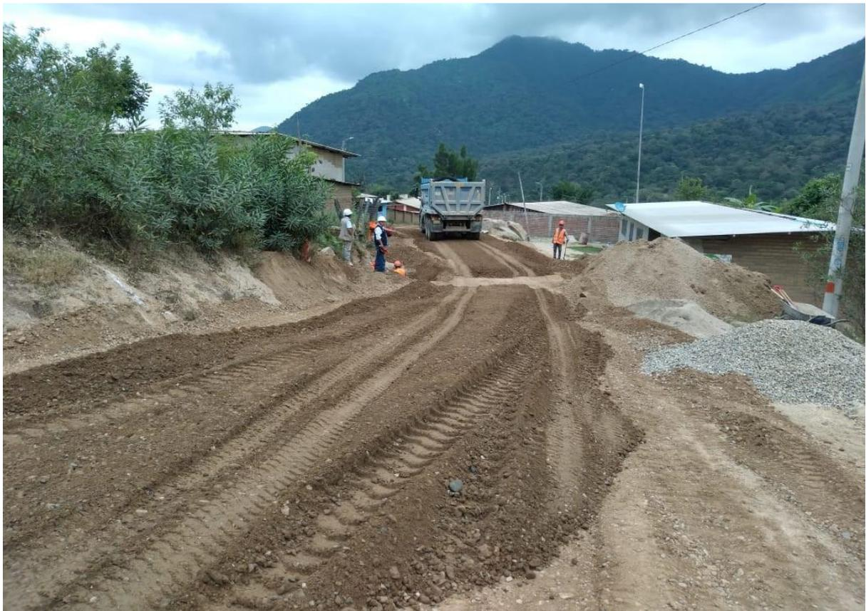
*Fotografía 04:* Trabajos de Colocación y Esparcido de Material Afirmado
