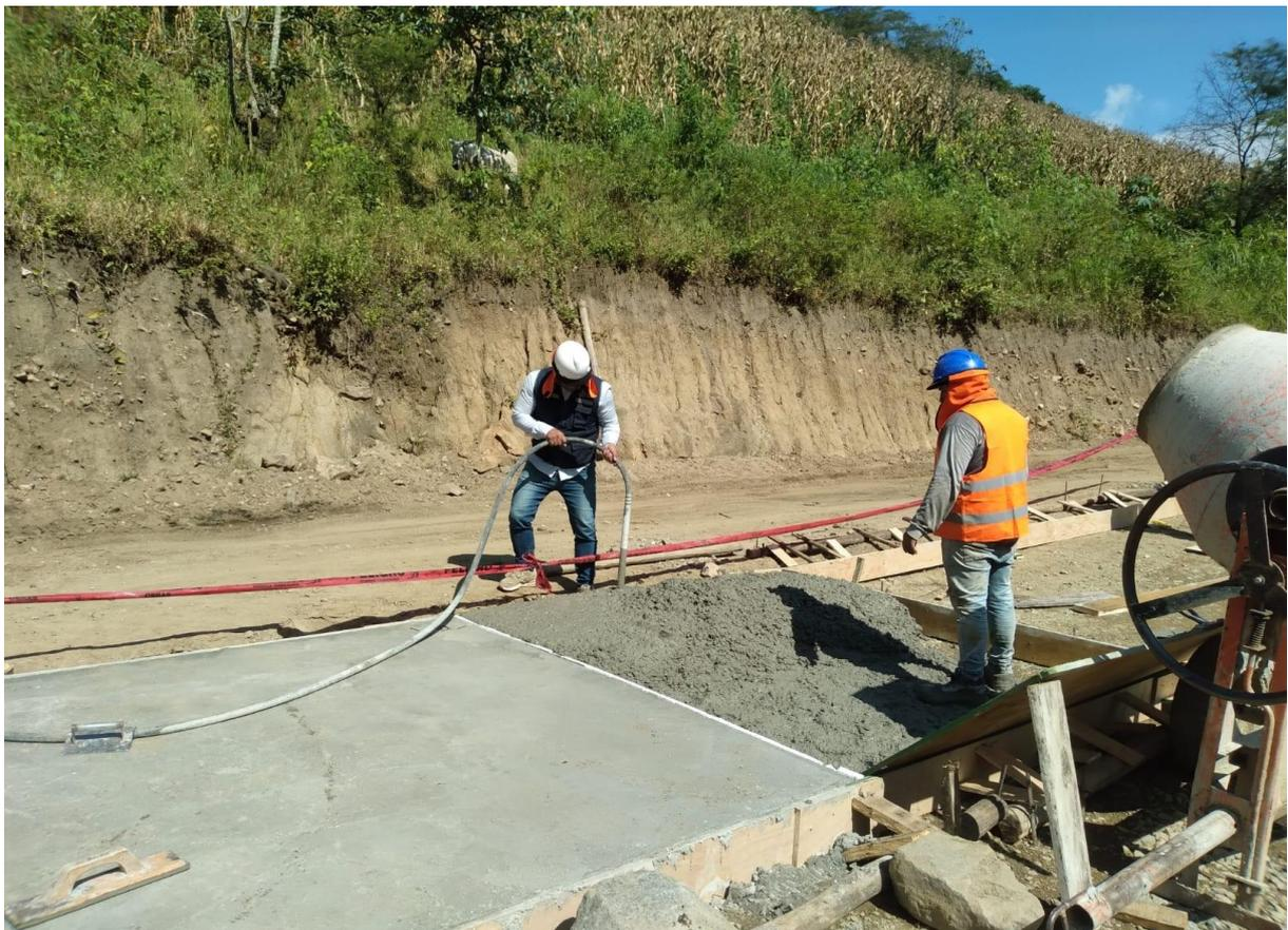
*Fotografía 13:* Vibrado del concreto simple en badén
