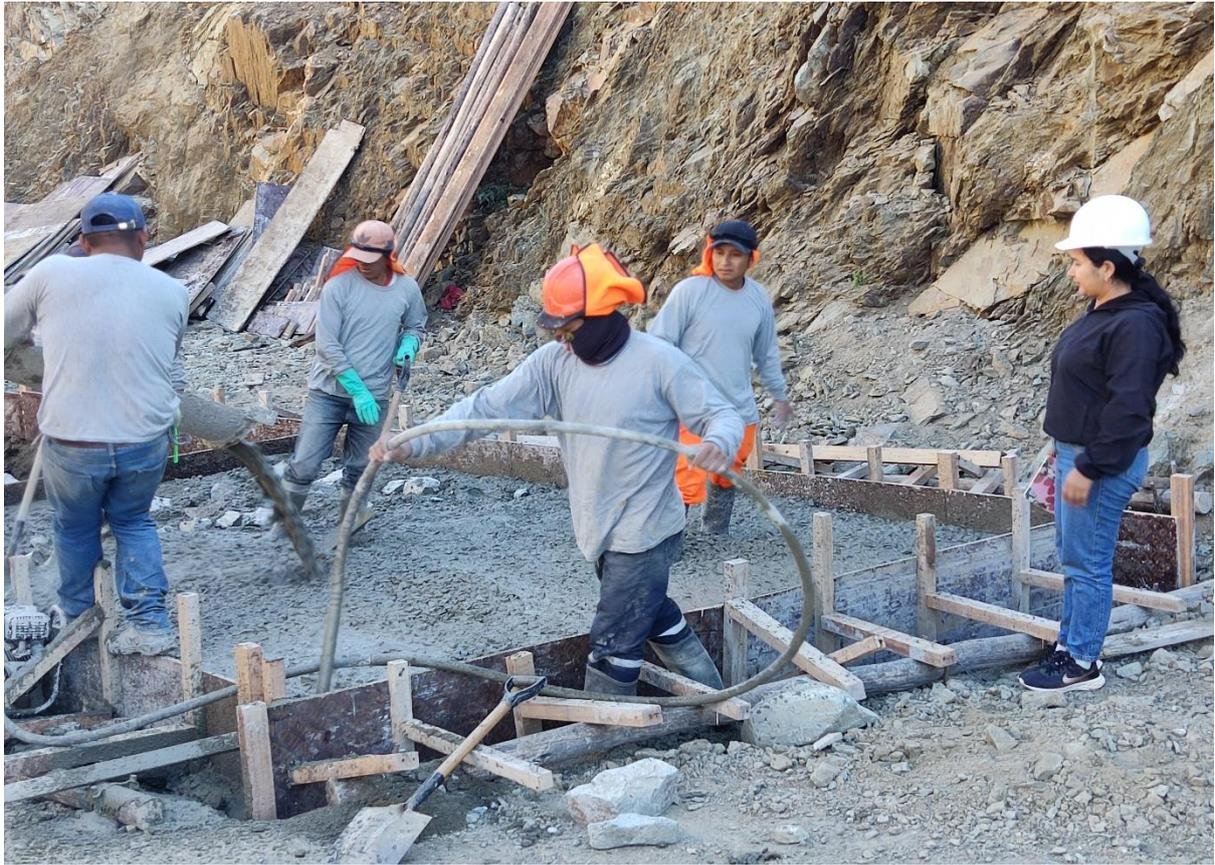
*Fotografía 05:* Vaciado de concreto simple en badén en rehabilitación de camino vecinal
