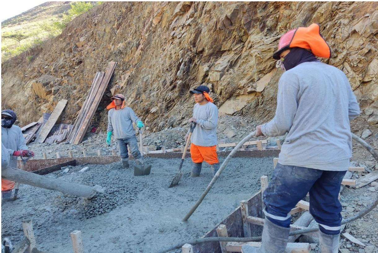
*Fotografía 07: Vibrado del concreto simple en badén*
