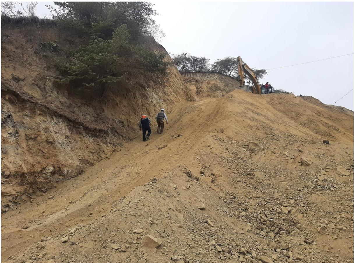
*Fotografía 02: Corte de terreno en Rehabilitación del camino vecinal Platanal - Frías*
