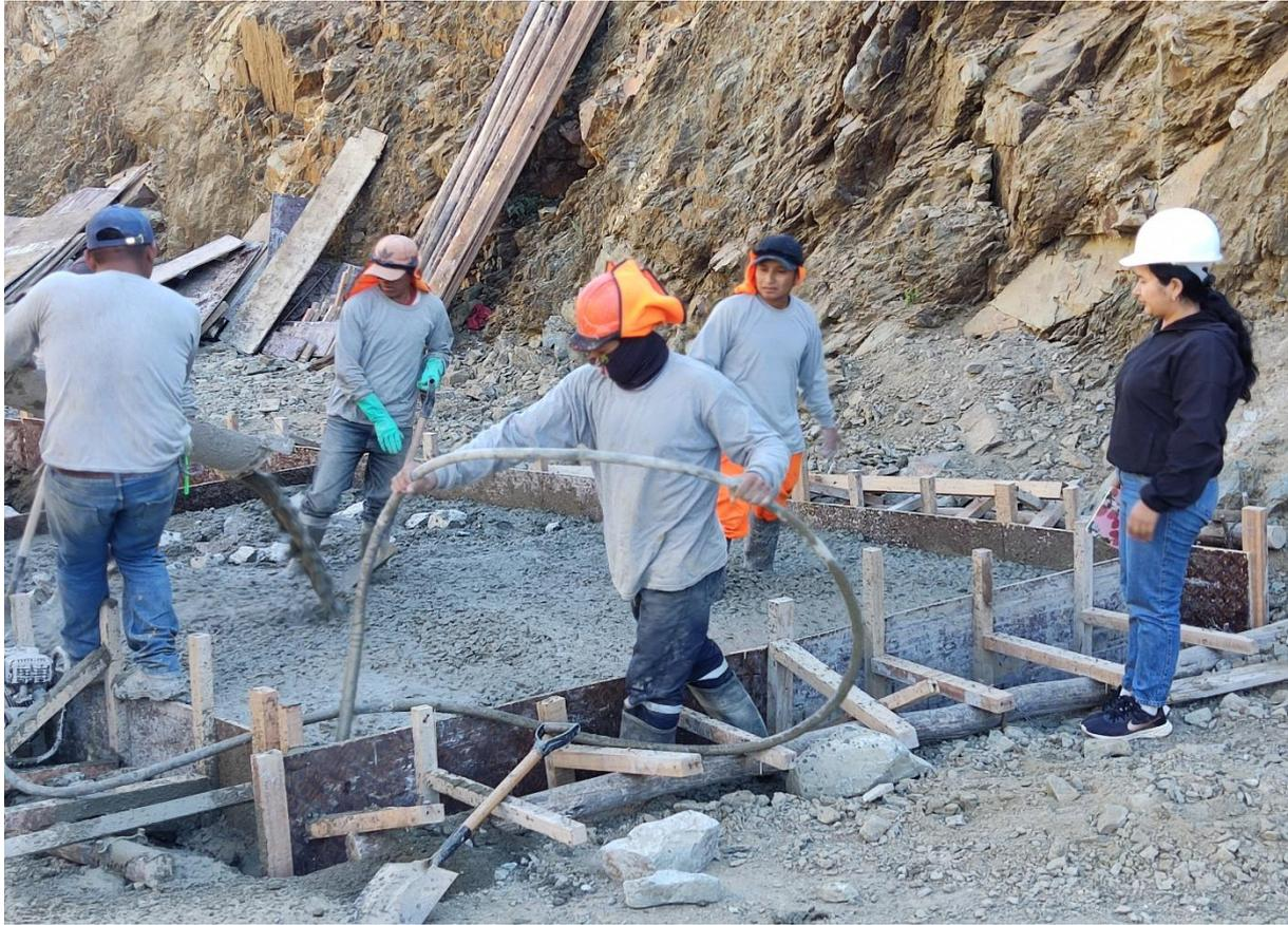
*Fotografía 07: Vibrado del concreto simple en badén*
