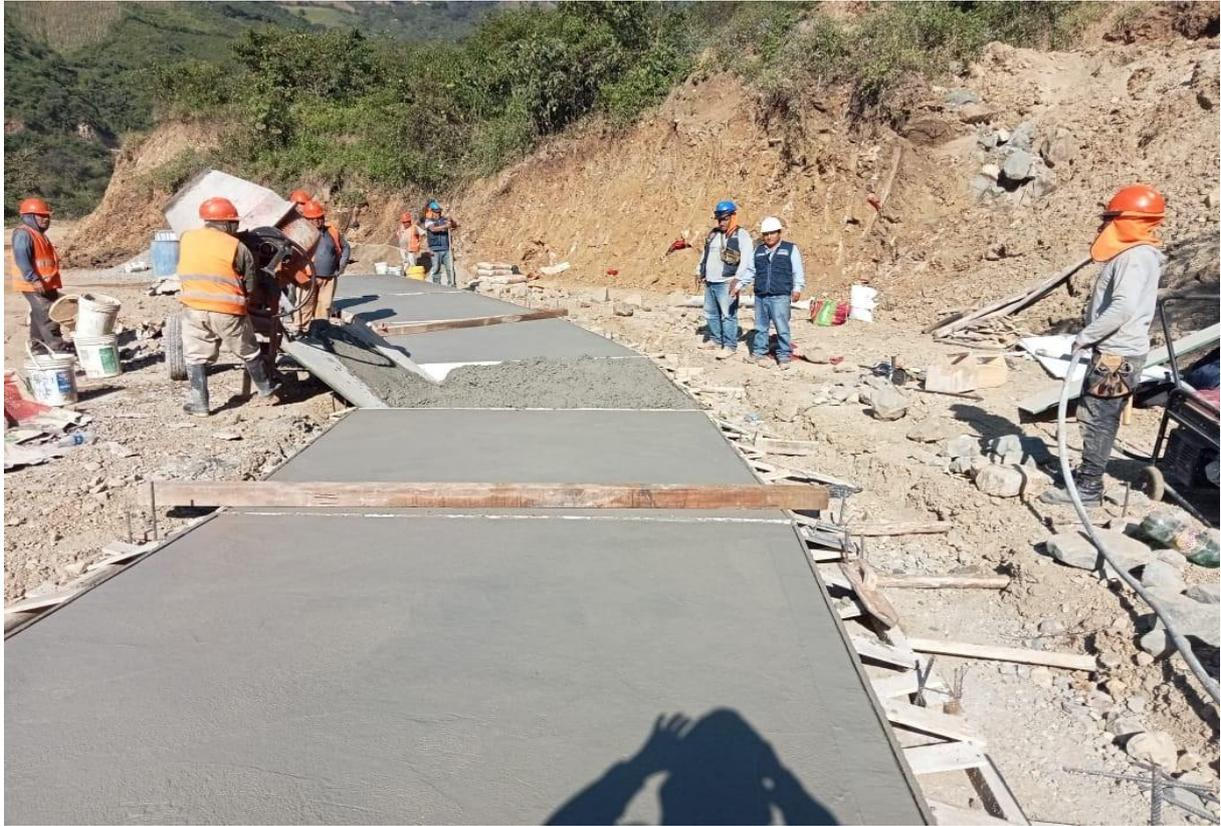
*Fotografía 12:* Trabajos de vaciado de concreto simple en badén
