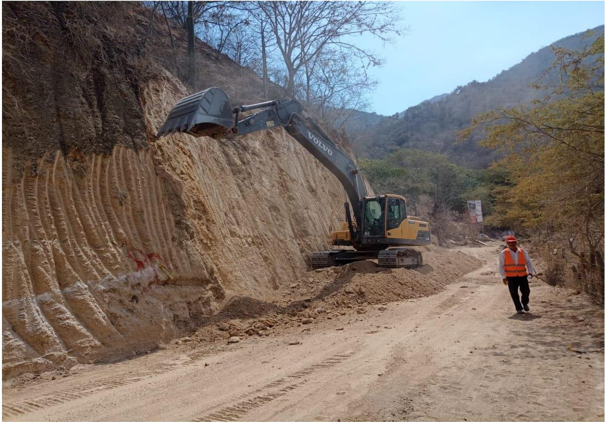
*Fotografía 03:* Corte de terreno en Rehabilitación del camino vecinal Platanal - Frías
