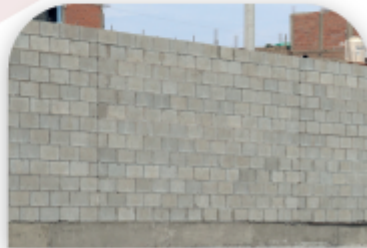
MURO REALIZADO CON KING BLOCK
