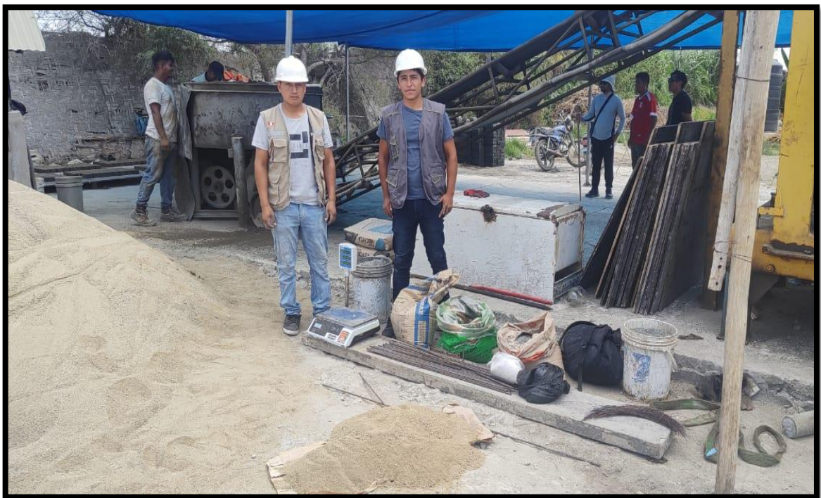
Foto N° 12: Se observa todos los materiales por cantidades medidas listo para su proceso de mezclado.
