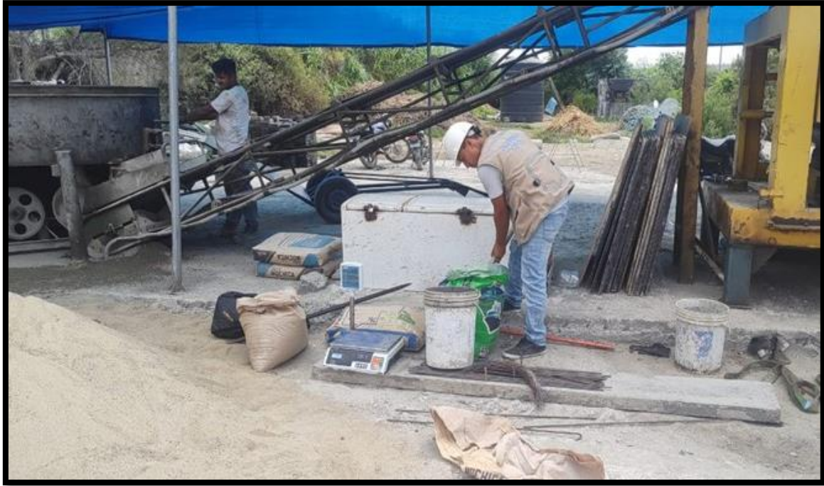
Foto N° 11: Se empezó a medir la cantidad de cada material a utilizar según la dosificación dado.
