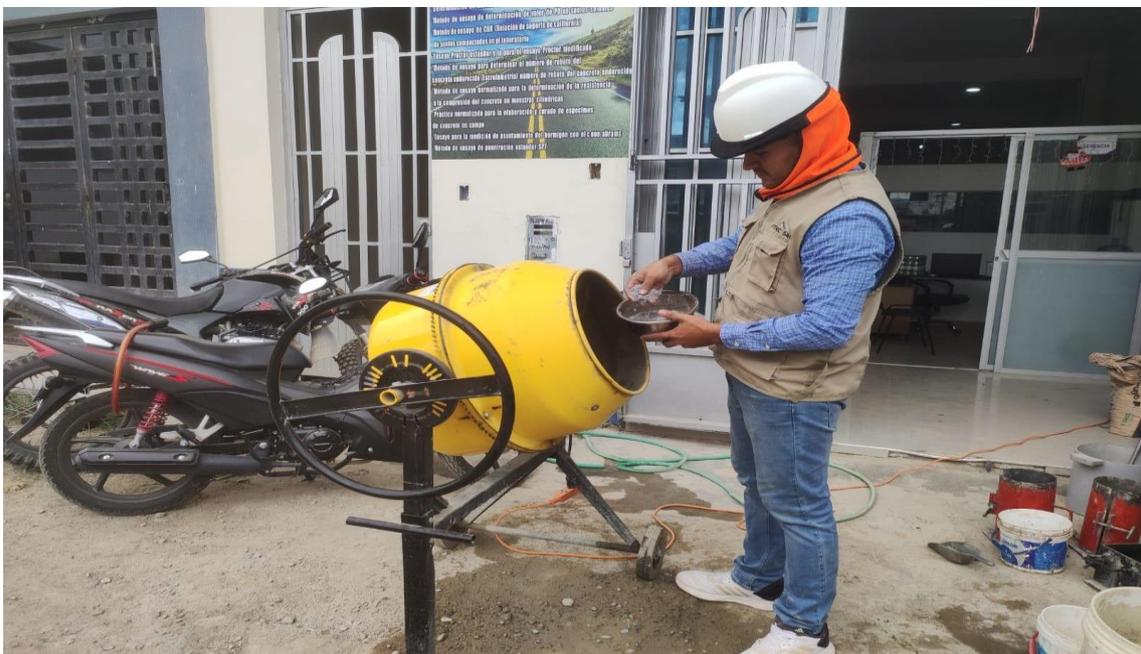
*Figura 18.* Incorporación de fibra de coco y ceniza de cascarilla de arroz a la mezcla de concreto
