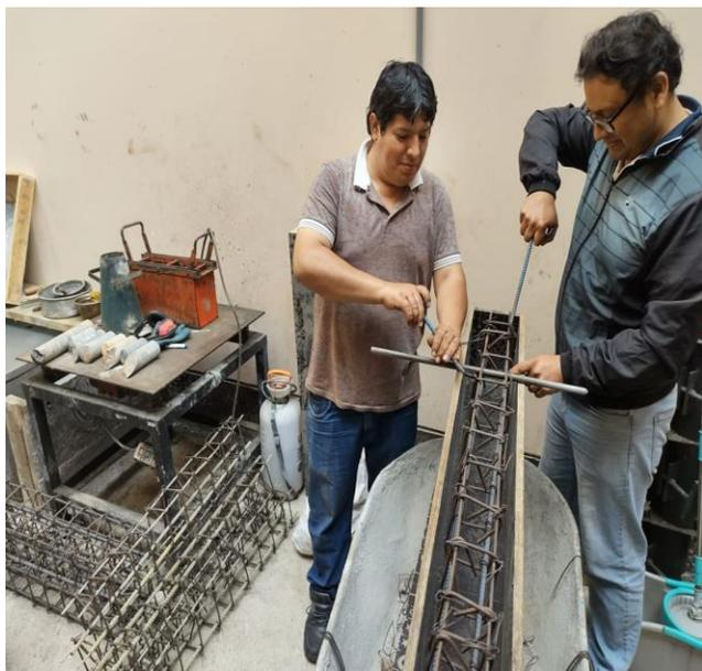
**Fotografía 05:** Amarres de los estribos de las Vigas de Acero y de Fibra de Vidrio.
