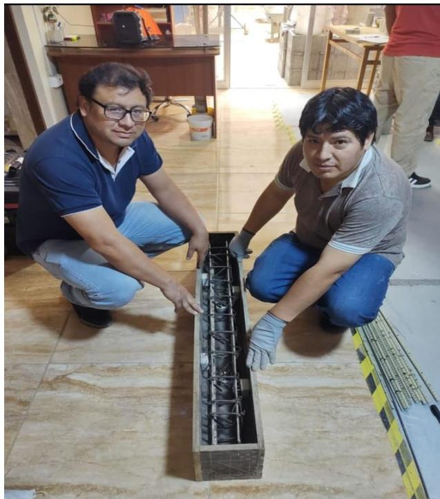
**Fotografía 07:** Encofrado de la Viga en el Molde con separadores de concreto de 0.025 mml.
