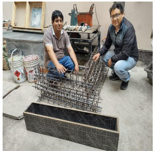
**Fotografía 06:** Terminado de armado de las Vigas de Acero y de Fibra de Vidrio.
