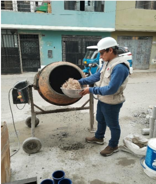
Vaciado de concreto con fibras
