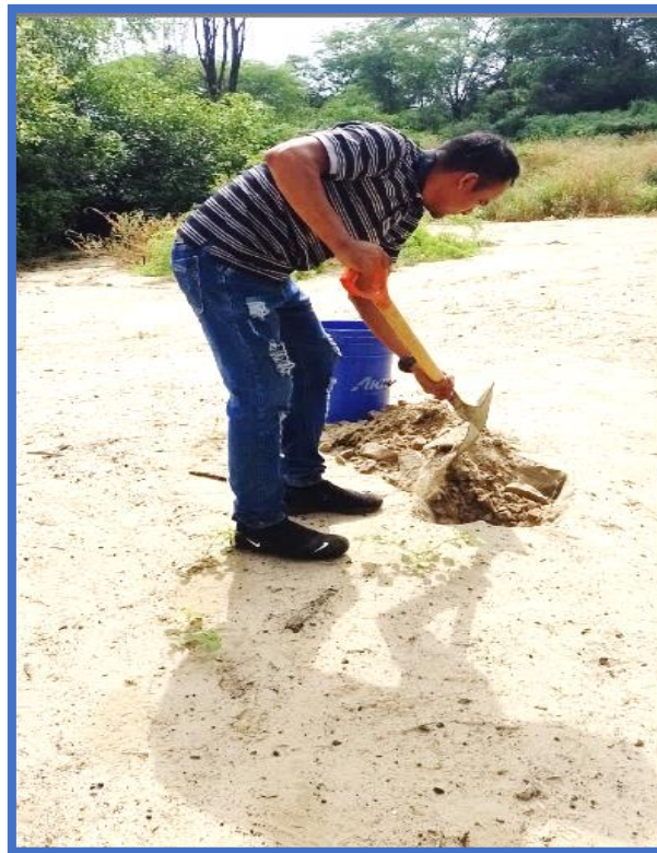
Fotografía 2 Lugar de acopio de la arena de duna
