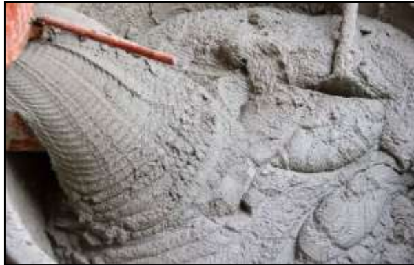
Figura 3. Conformación de la mezcla del mortero Fuente: https://bitly.ws/YfEB
