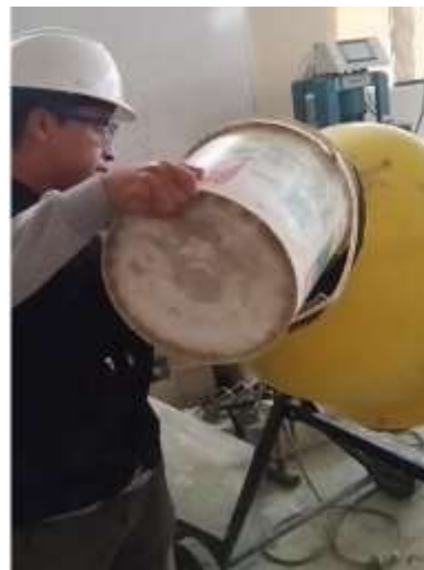
Fotografía 4. Elaboración del mortero.
