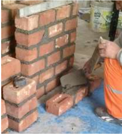
Fotografía 1. Asentado de Muretes
