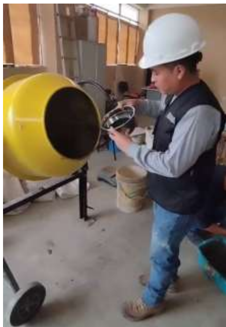
Fotografía 3. Preparación de mezcla adición F.C.
