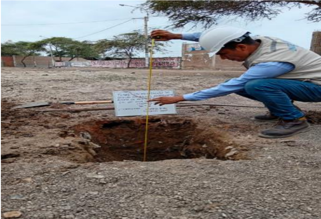
Figura 6: Av. Villa Hermosa Chiclayo, excavación de calicata N° 2 (km 1+00), 2023
