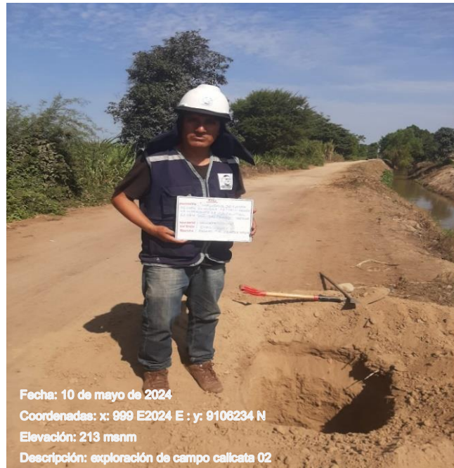
Figura 7: Exploración de calicatas.
