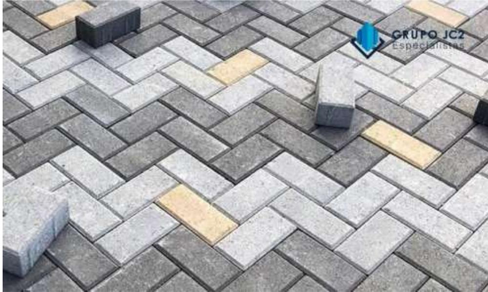
*Figura 6.* Adoquín de concreto
