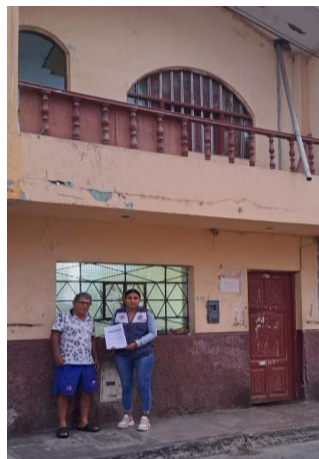
Figura 26. Vivienda N°3 de dos niveles.
