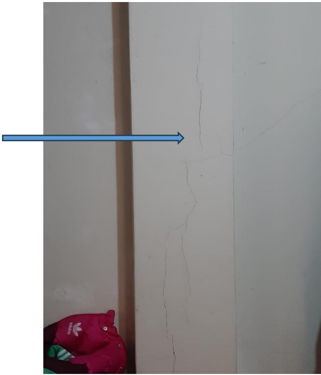
En estas fotos se puede ver las cangrejas en las columnas de un dormitorio de la vivienda N°1 (dos pisos)
