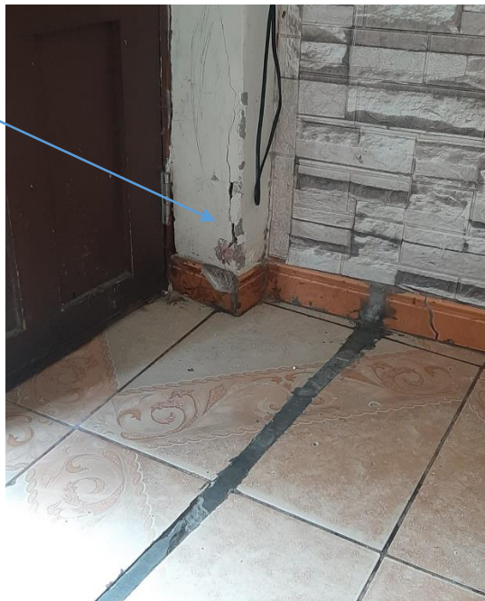
En esta vivienda se puede apreciar las cangrejas que existentes en columnas como en la losa aligerada
