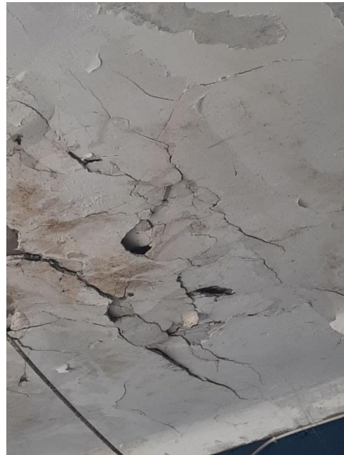
Acá se puede apreciar como existe un pandeo en la losa aligerada, con múltiples cangrejas en donde en tiempos de lluvia filtra toda el agua
