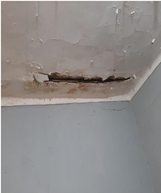
Acá se puede apreciar como existe un pandeo en la losa aligerada, con múltiples cangrejas en donde en tiempos de lluvia filtra toda el agua
