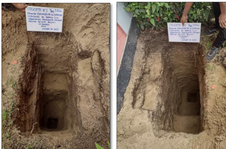
Figura 1. Excavación de calicatas
