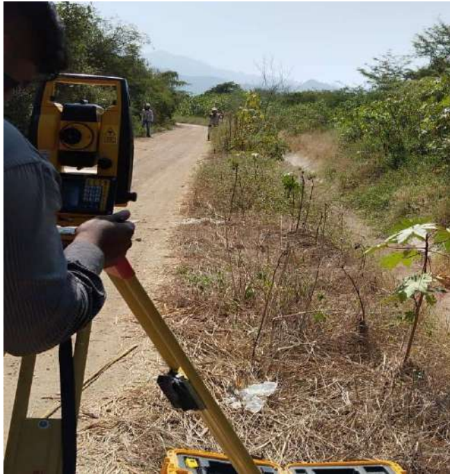
Imagen 1: realización del levantamiento topográfico, Jayanca, 2023
