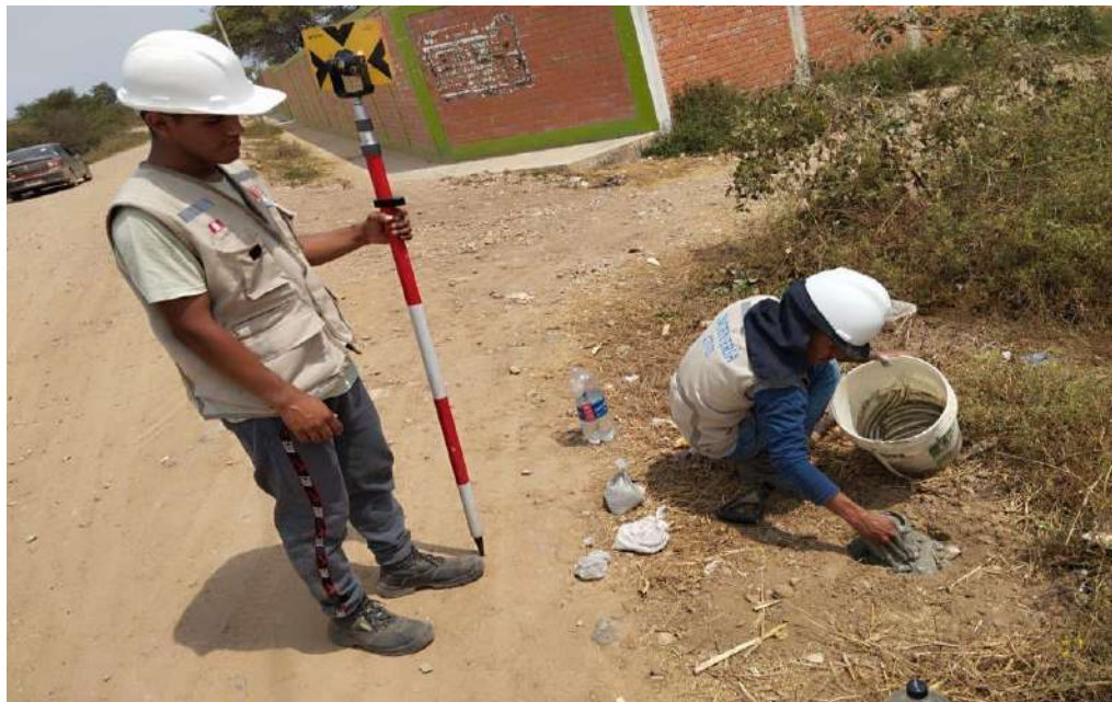
Imagen 14: Colocación del punto Bm 12, Jayanca, 2023
