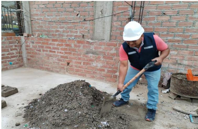
**Figura 8:** proceso de mezclado de los insumos.
