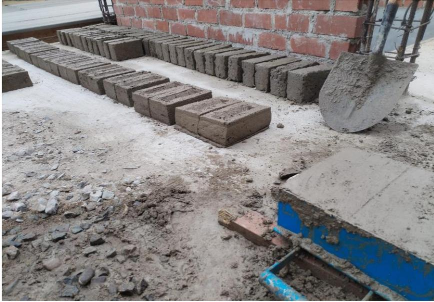
**Figura 11:** Secado de ladrillos durante 24 horas en ambiente fresco.
