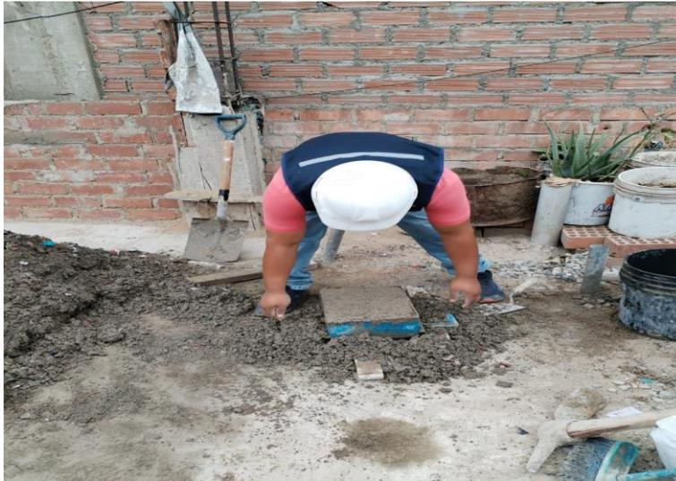
**Figura 9:** Proceso de moldeamiento de los ladrillos.
