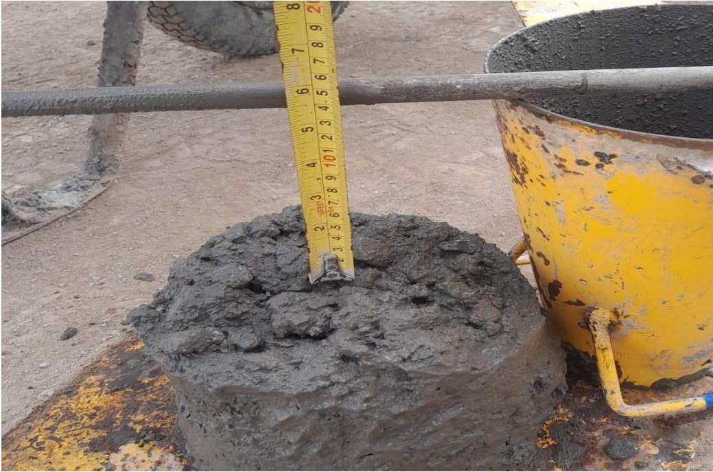
Figura 9. Ensayo de prueba del Slump
