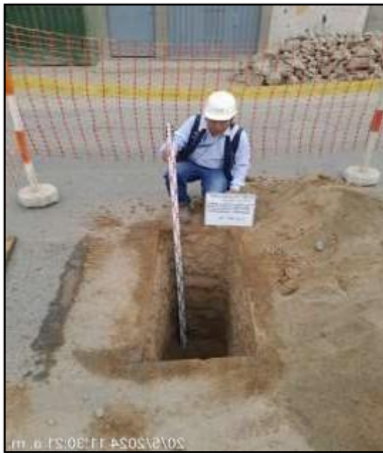
Figura 13. Excavación para la calicata número 1.
