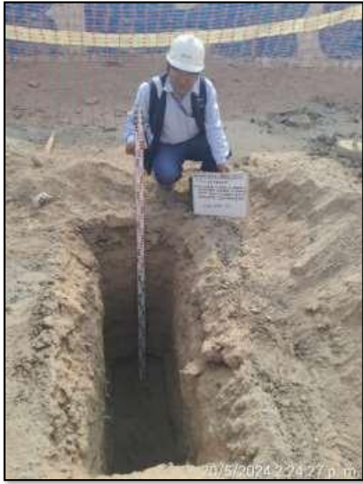
Figura 15. Excavación para la calicata número 3.
