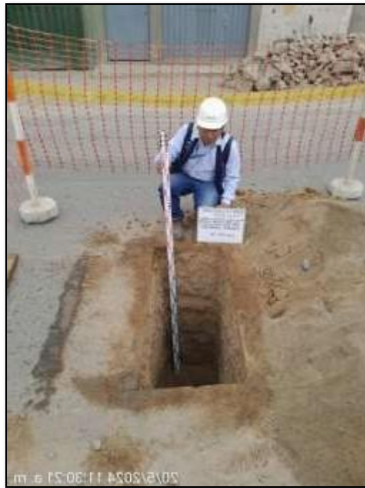
Figura 5. Calicata N° 1, para extracción de la muestra.
