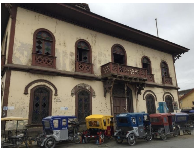
FIGURA 3. Fachada actual de la ex Aduana de Paita
