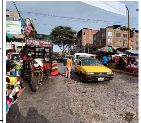
Pistas en mal estado e interrumpidas por comerciantes informales
