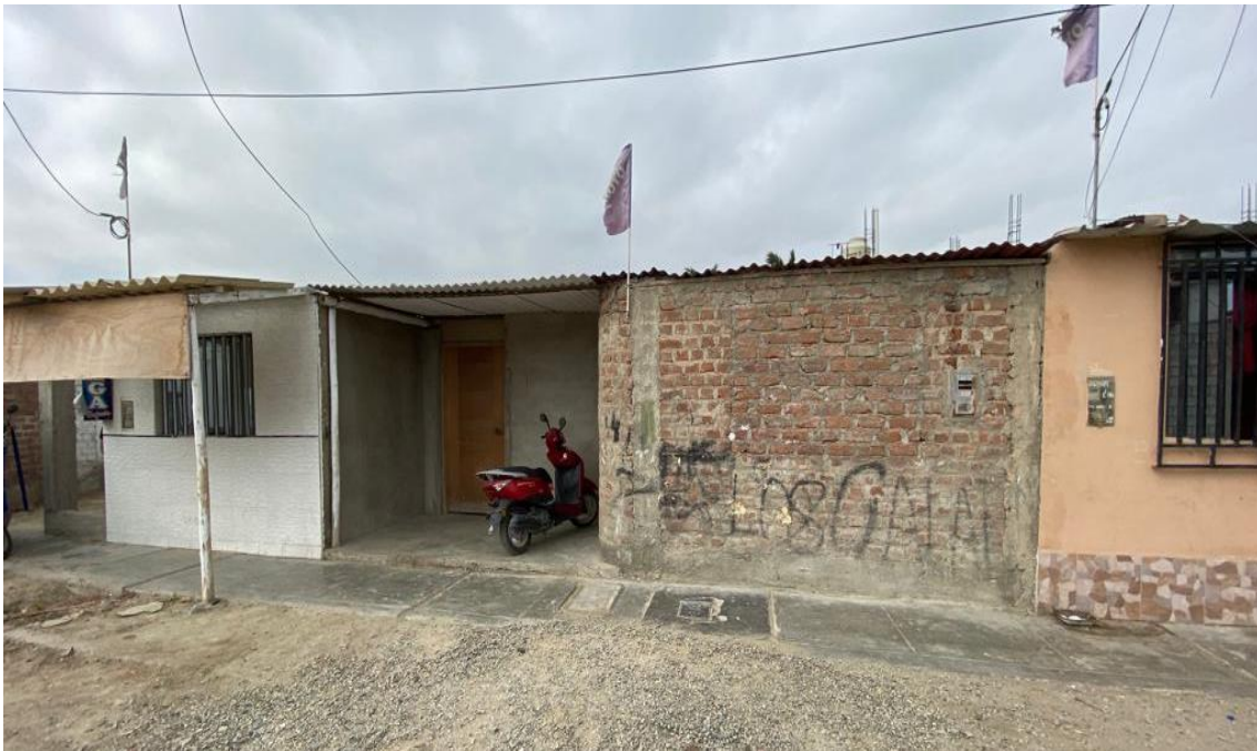
Figura N°5: Viviendas sin correcta ventilación e iluminación
