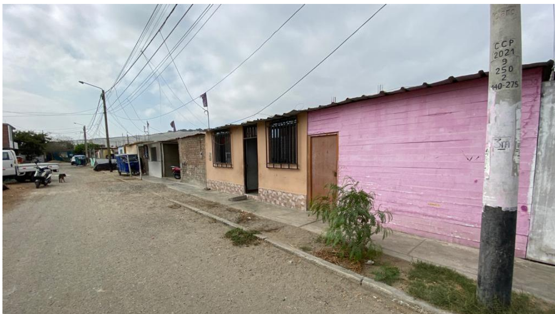
Figura N°4: Viviendas sin materiales aislantes
