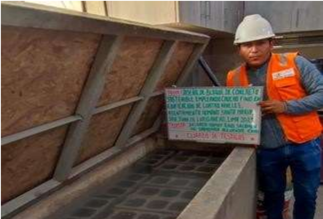
Fotografía: Curado de bloque de concreto para los 7, 14, 28 días.
