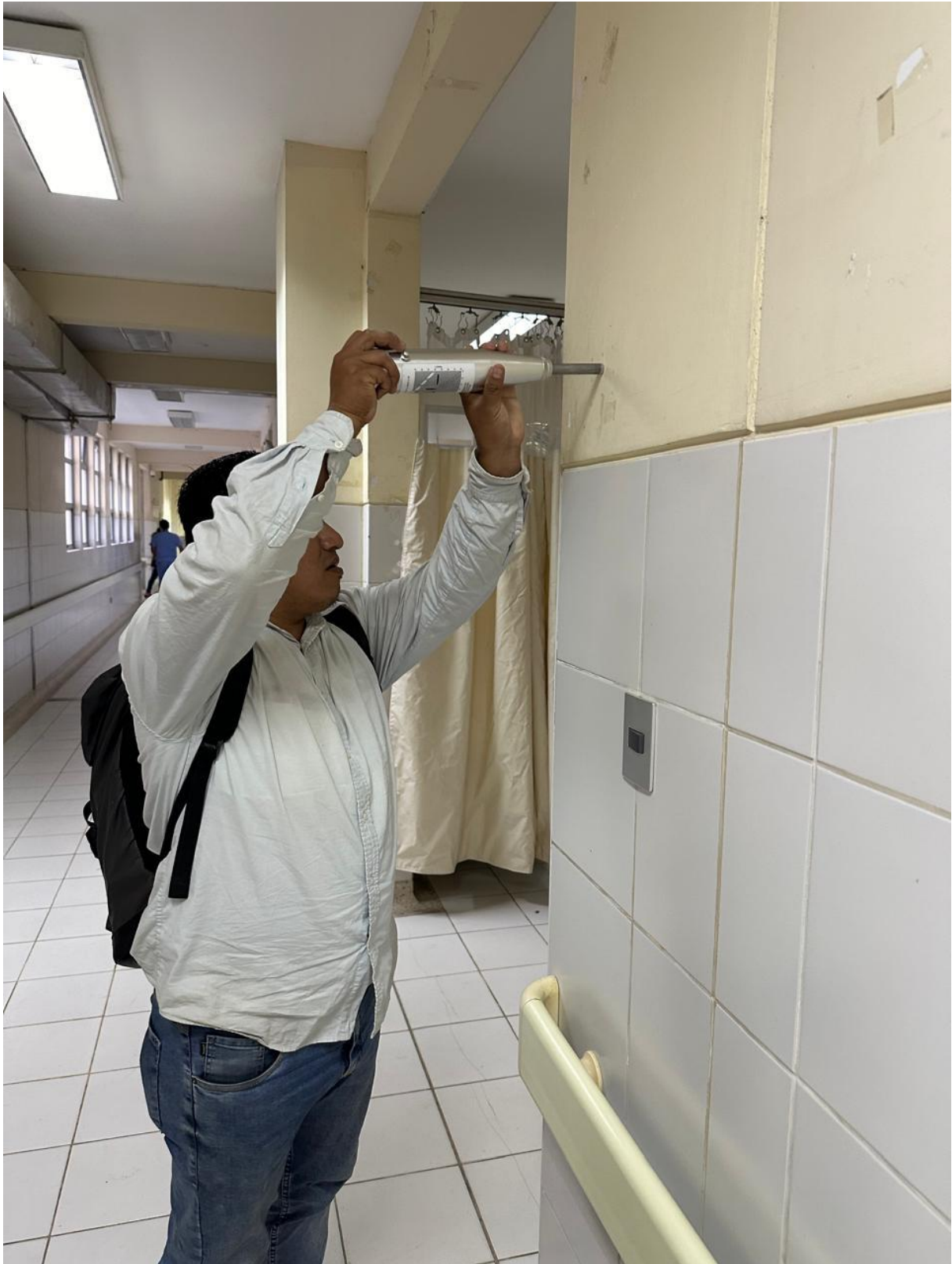
Figura 83: Ensayo de esclerómetro en columna
