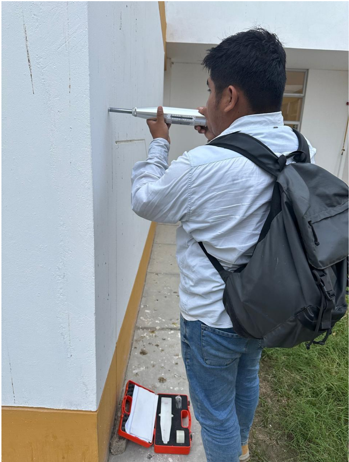
Figura 81: Ensayo de esclerómetro en columna
