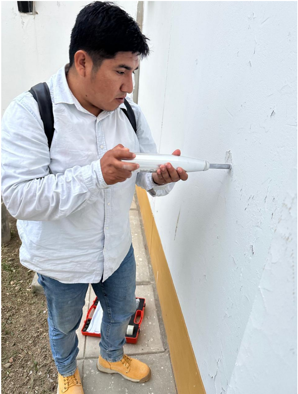
Figura 82: Ensayo de esclerómetro en placa
