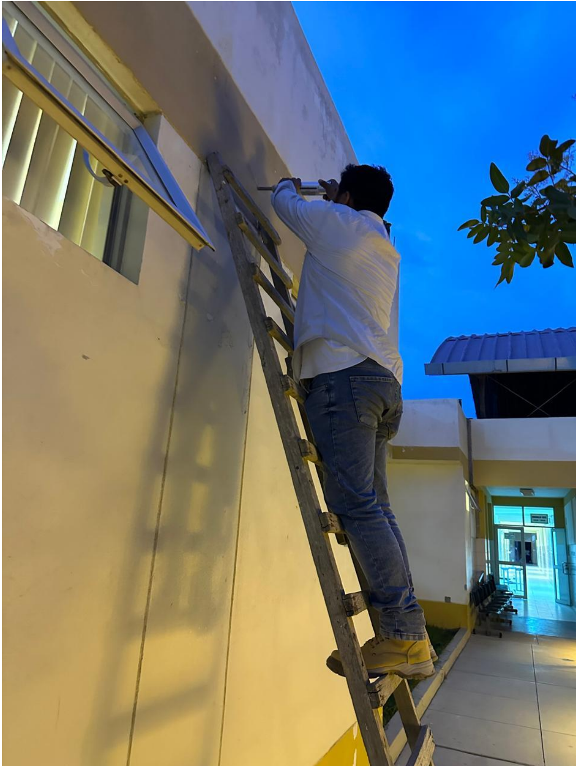
Figura 80: Ensayo de esclerómetro en viga
