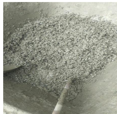
Figura 20. Obtención de la mezcla del concreto permeable
