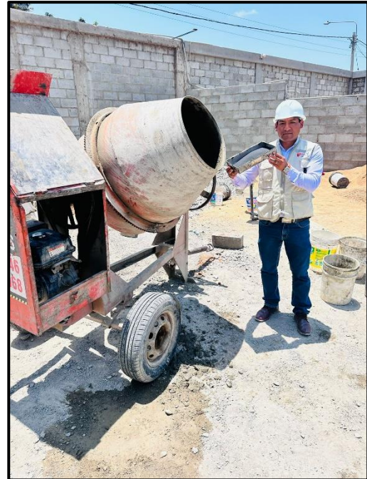
Colocación de la ceniza a la mezcla
