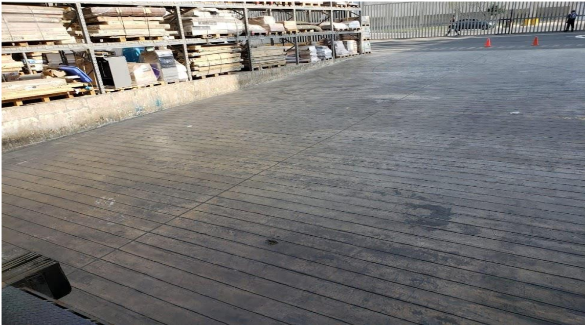
Zona de descarga limpia luego de recepcionar
