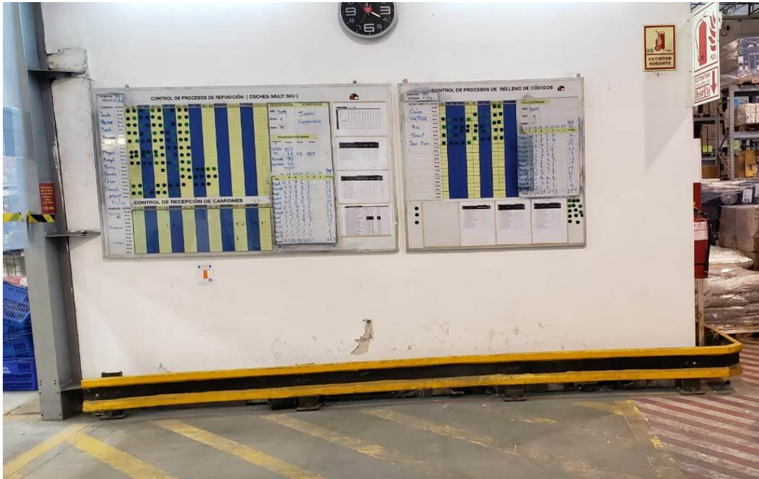
Paneles de control para controlar los procesos
