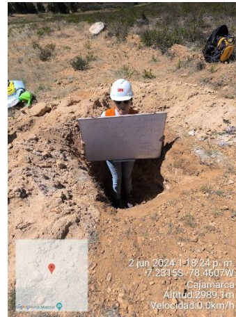
Imagen 10. Identificación e excavación de la Calicata N ° 4 en la prog 4+00 Km.
