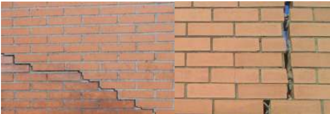
Figura 1: Distintas formas de separación en las juntas
