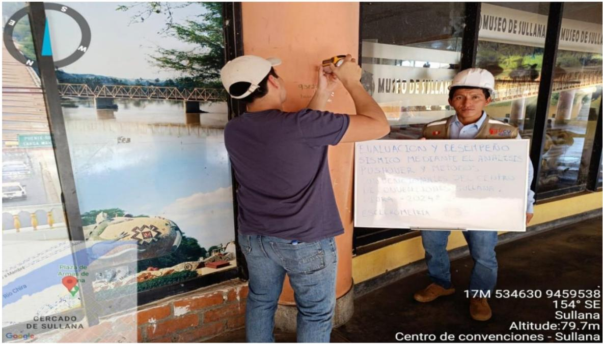
Ensayo de esclerometría (columna c-13)
