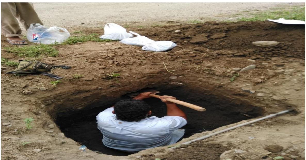
En la segunda calicata, identificada como C-2, situada en las coordenadas 17M 534585 9459542, con una orientación de 311° NW y una altitud de 16.4 metros, se llevó a cabo un procedimiento similar. La excavación manual alcanzó los 3 metros de profundidad, y las muestras de suelo obtenidas se destinaron a ensayos de laboratorio. Durante la excavación, se describieron detalladamente las características del suelo encontrado, siguiendo las normativas ASTM D-2488.
