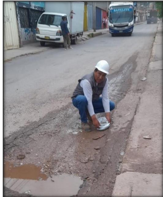
**Se muestra en la figura la toma de muestra del asfaltado deteriorado para llevarlo al laboratorio.**
