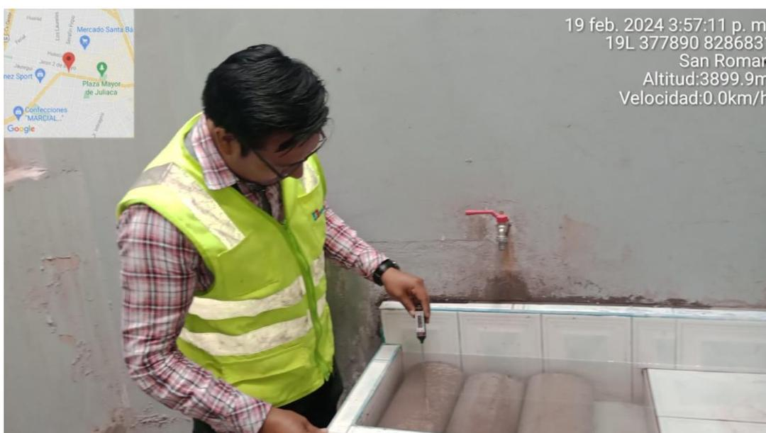
*Figura 14. Curado de los cilindros de concreto*
