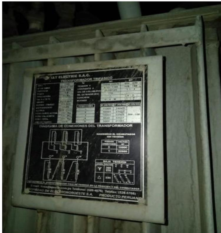
**Figura 2:** Placa de datos del transformador de potencia de 75kva.
