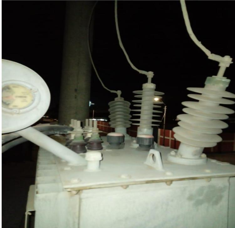
**Figura 1:** Transformador de potencia de 75kva.
