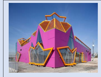
Fachada Principal de Casal de la Juventud de Rivas Vaciamadrid
