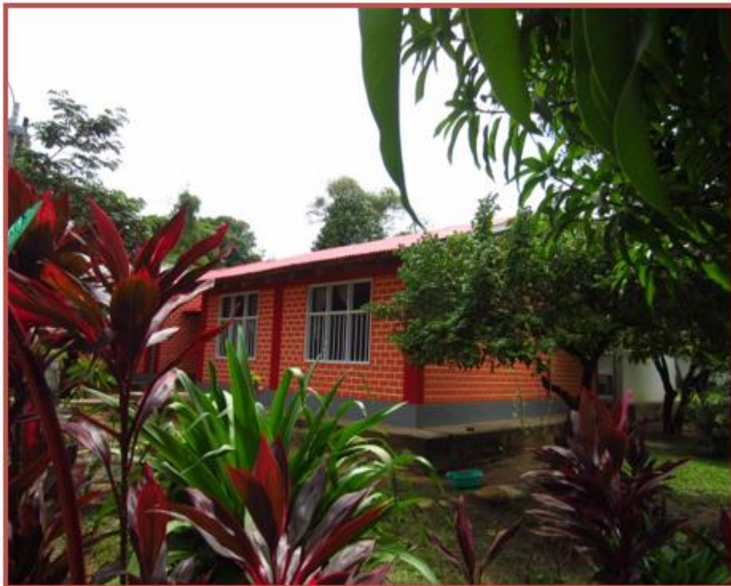
Imagen N° 52: vista de los dormitorios
