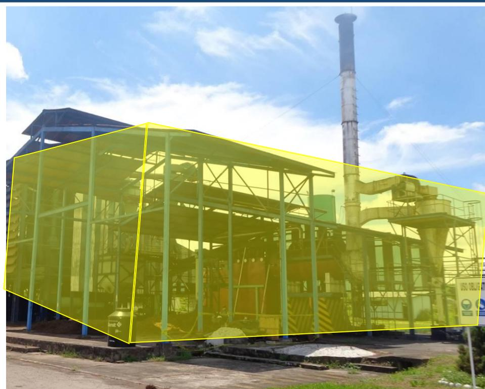
La zona del caldero protegido en un 50% por estructura metálica y cobertura metálica para la ventilación correspondiente.
