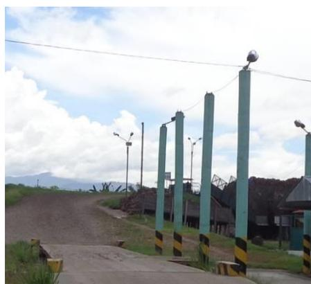
La zona de balanza no cuenta con una estructura para protección de lluvias y sol está conformado de 4 metros de ancho con 20 metros de largo.
