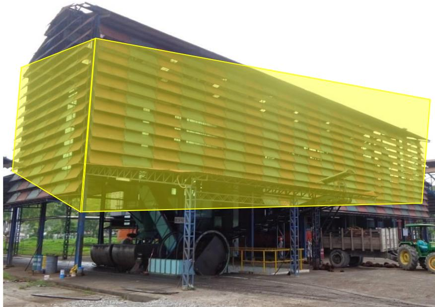
La zona de extracción es una zona que tiene que estar al aire libre para la ventilación e iluminación tiene una cobertura de metal.
