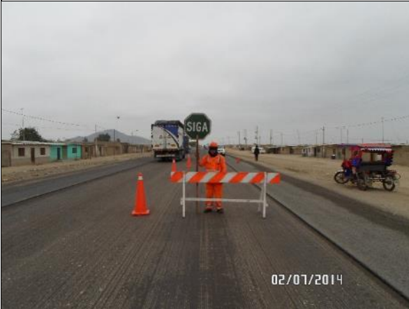
Restricción de tránsito con barrera y Presencia de Vigía – Carretera Panamericana.
