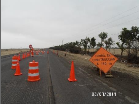
Restricción del tránsito con Conos y Barriles de seguridad
