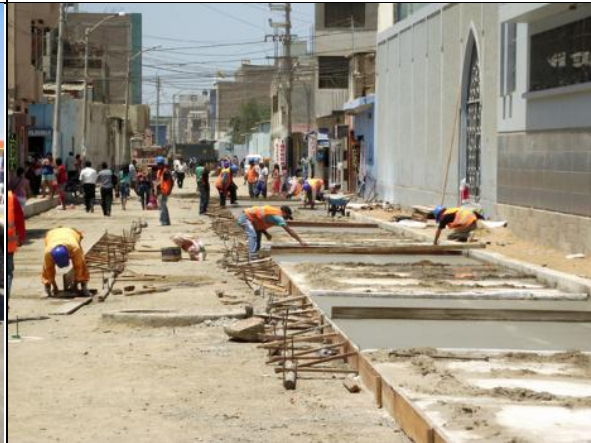
Personal con sus EPP - Pavimentacion Calle Leoncio Prado Chiclayo
