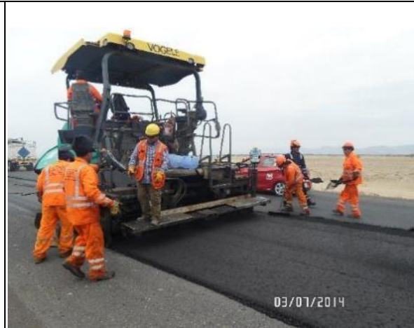
Personal con sus EPP - Pavimentacion Via de Evitamiento
