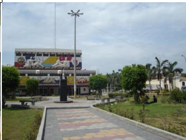
Pavimentación con adoquinado de Concreto Parque al costado del Ministerio Publico
