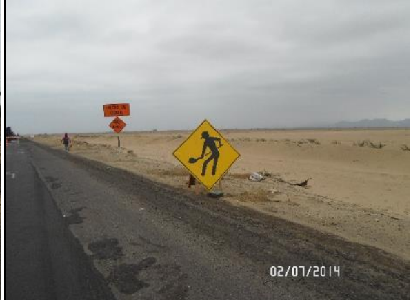
Colocación de Señales Informativas durante la ejecución de trabajos de pavimentación
