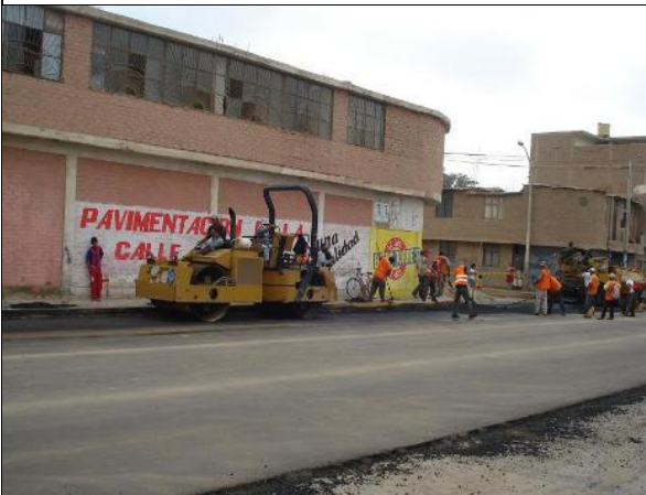
Restricción de vehículos con Cinta de señalización – Av. Cajamarca Chiclayo
