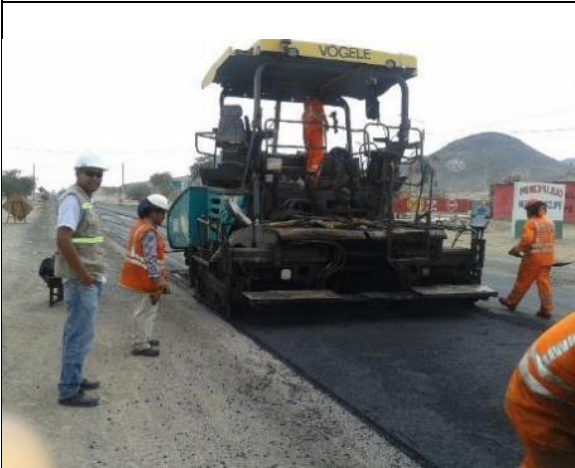
Personal con sus EPP - Pavimentacion de Panamerica
