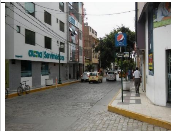
Pavimentación con adoquinado de piedra Calle María Izaga
