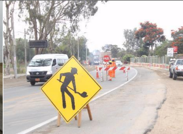
Colocación de Paneles de preventivos - Carretera Panamericana.
