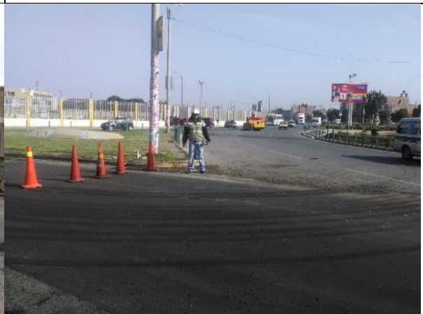
Bloqueo de Via con Conos de seguridad Carretera de Evitamiento Chiclayo km-786
