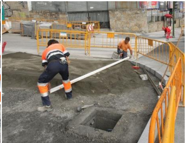
Delimitación de área de trabajo con Barreras de seguridad
