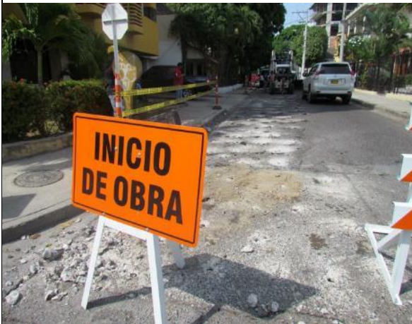
Señal Informativa en obra para delimitar área de trabajo
