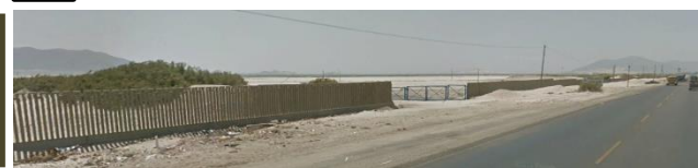
B CERCO DE CONCRETO
