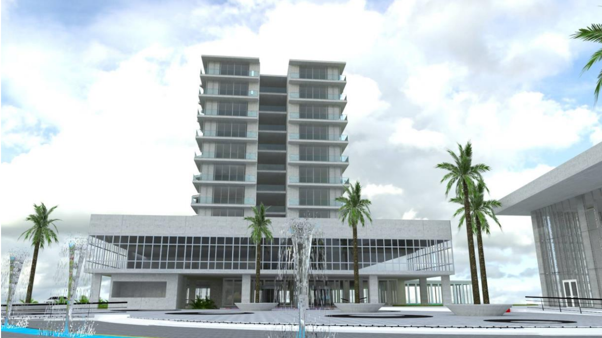
Imagen N° 28: Vista frontal del ingreso principal
