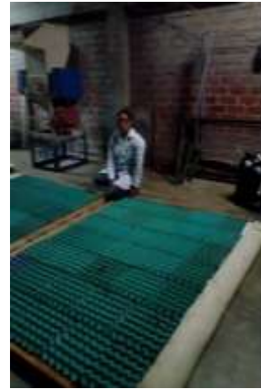
Fig.6 Armado de la caja acústica
